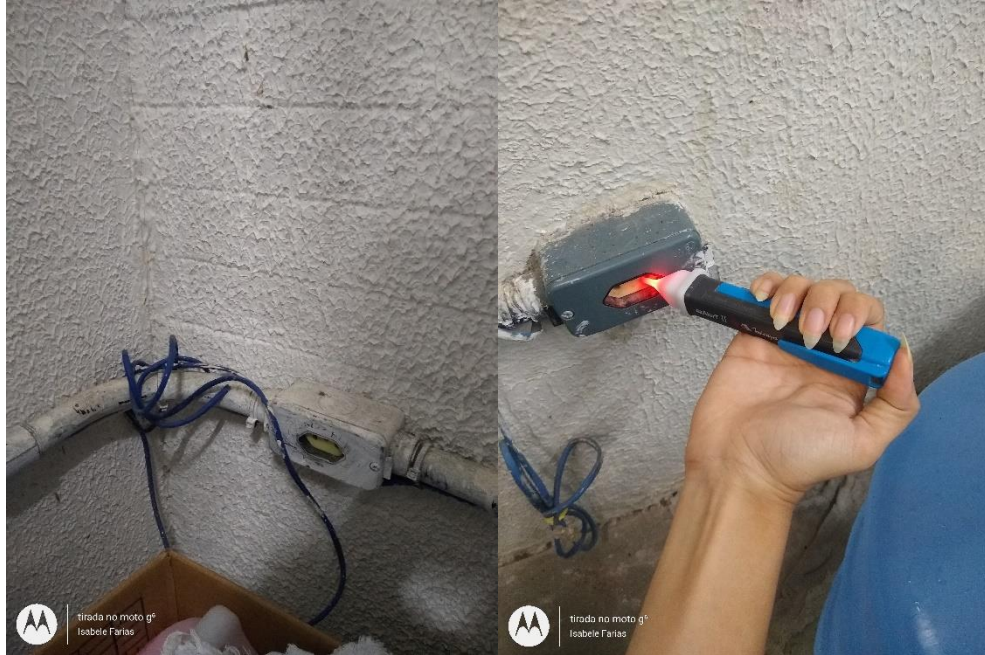
Figura 42 - Recorte no sistema de instalação elétrica: a) cabeamento solto, b) verificação de corrente
