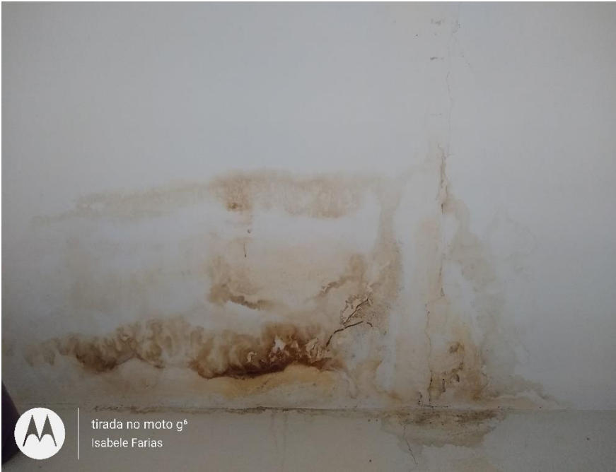
Figura 59 - Não conformidade sistema de revestimento observação 9
