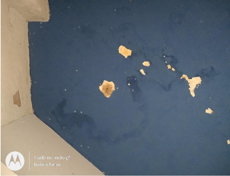
Figura 56 - Não conformidade sistema de revestimento observação 6
