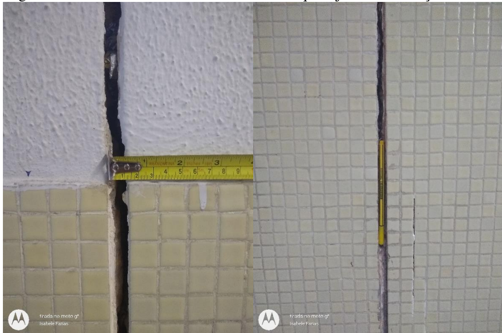
Figura 24 - Recorte no sistema estrutural: destaque a junta de dilatação
