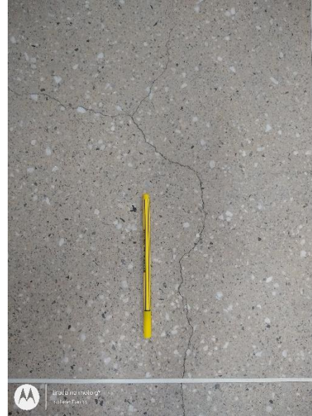
Figura 57 - Não conformidade sistema de revestimento observação 7
