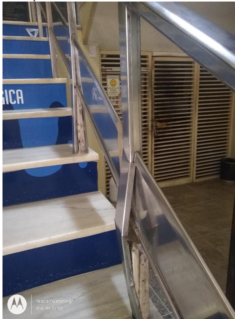
Figura 70 - Não conformidade sistema de esquadrias observação 20
