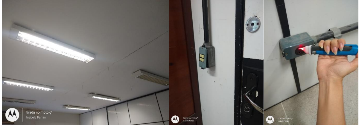
Figura 38 - Recorte no sistema de instalação elétrica: a) iluminação b) pontos elétricos c) verificação de tensão elétrica
