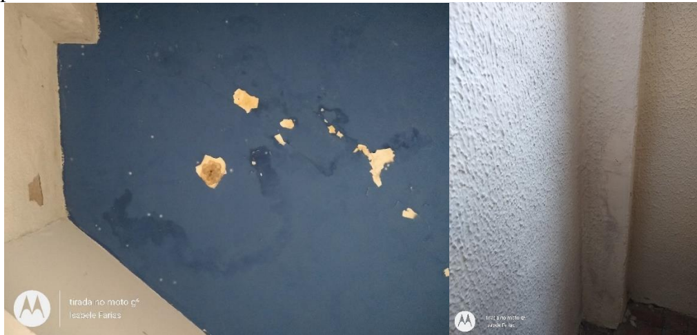
Figura 44 - Recorte no sistema de revestimento: a) pintura de teto b) pintura de parede
