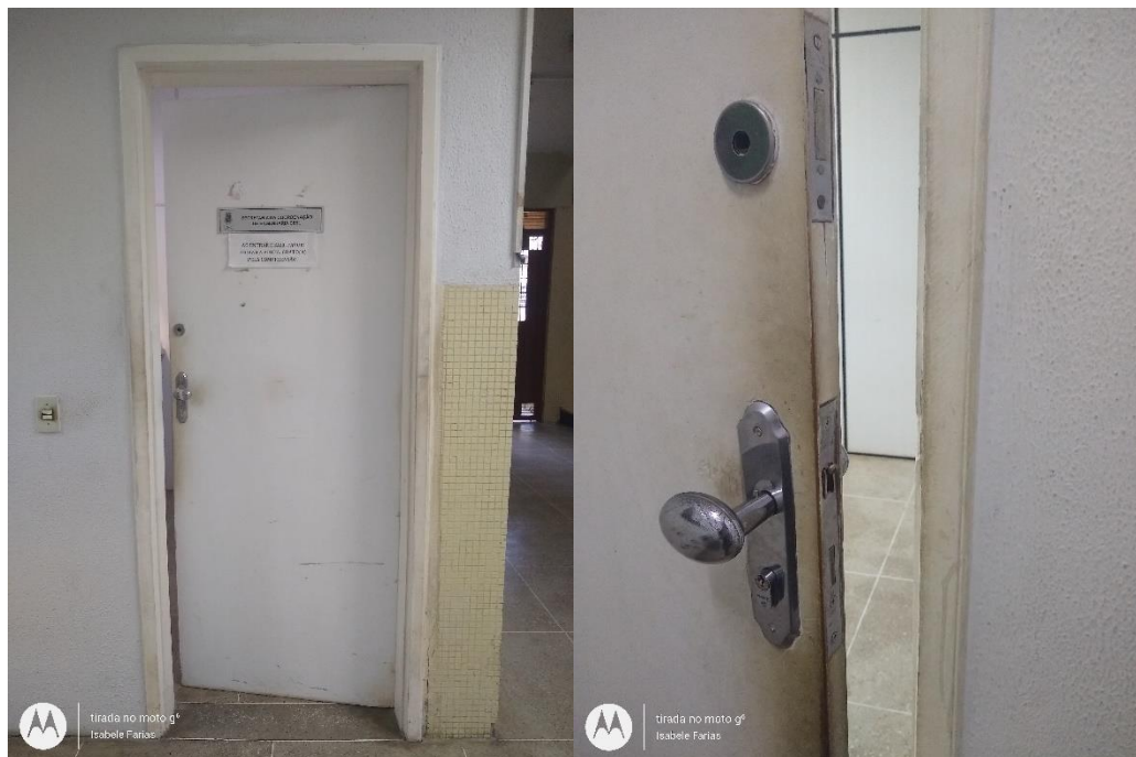
Figura 35 - Recorte no sistema de esquadria: a) porta visão exterior, b) porta visão interior
