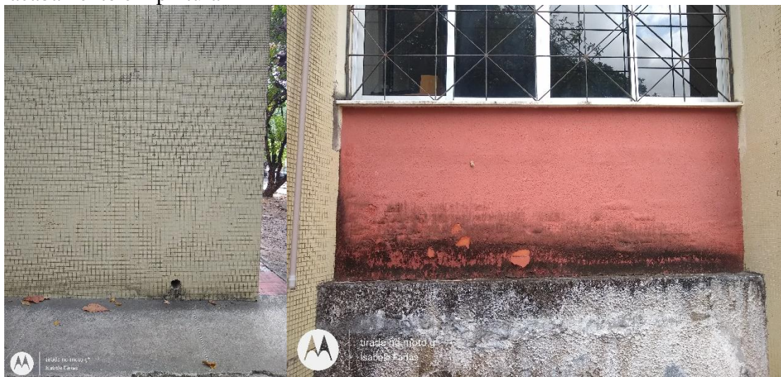
Figura 30 - Recorte no sistema de revestimento: a) acabamento cerâmico b) acabamento em pintura
