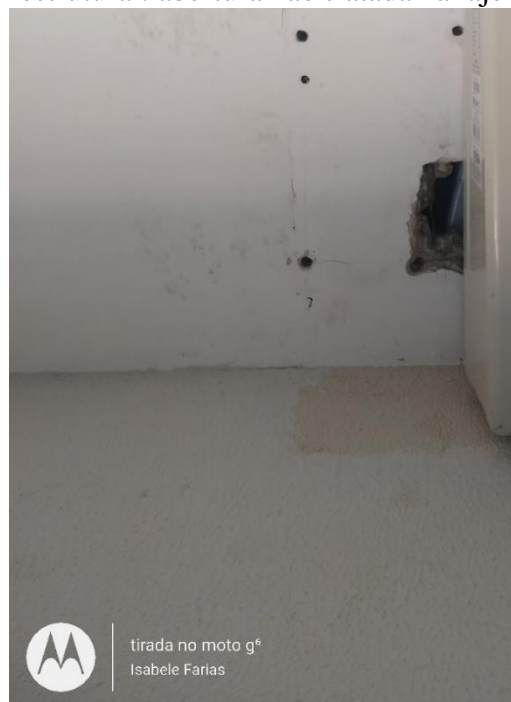
Figura 14 - Recorte no sistema estrutural: abertura não tratada na laje
