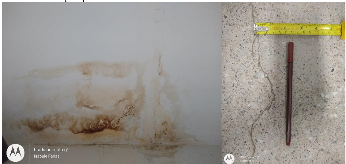
Figura 37 - Recorte no sistema de revestimento: a) revestimento de pintura de teto e parede b) revestimento de piso polido
