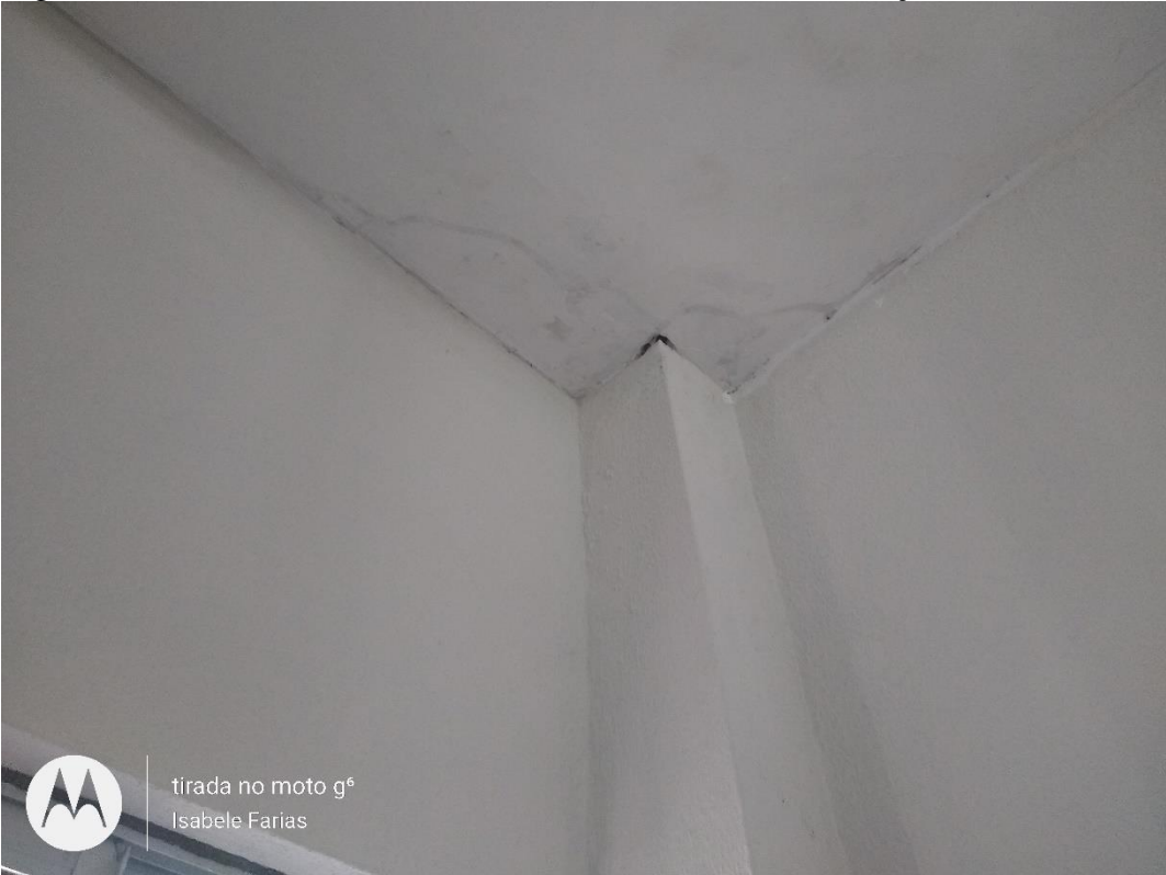
Figura 61 - Não conformidade sistema de revestimento observação 11
