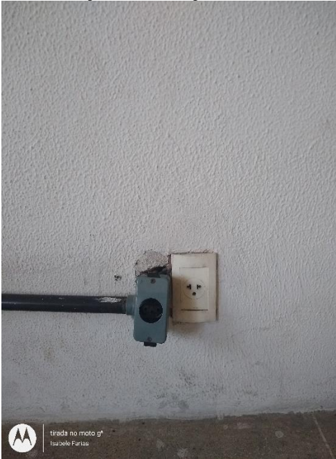
Figura 65 - Não conformidade sistema de instalação observação 15
