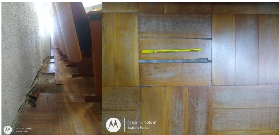
Figura 45 - Recorte no sistema de revestimento: c) revestimento de piso em madeira
