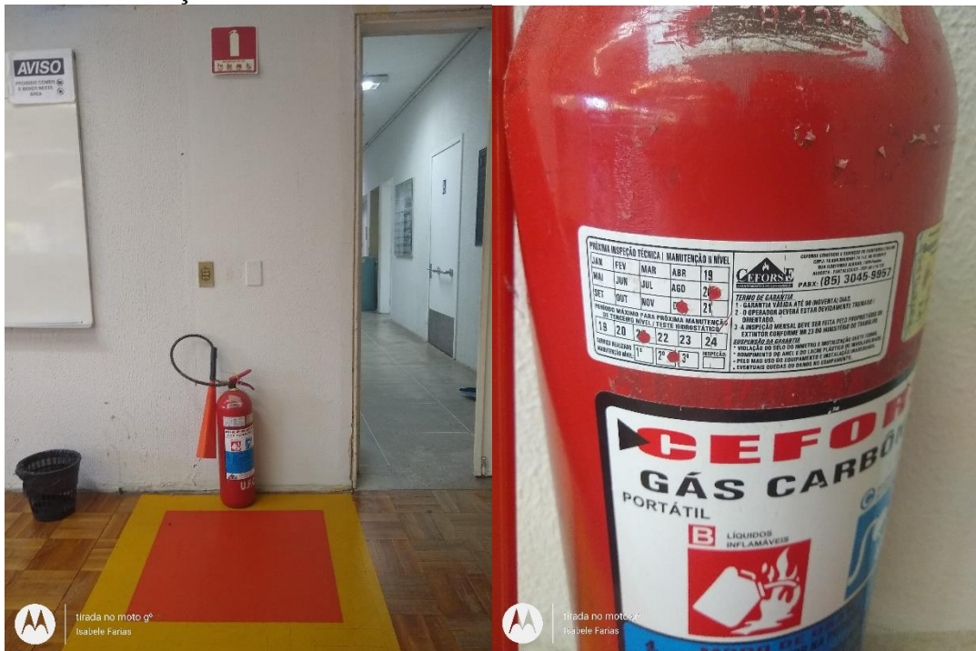
Figura 33- Recorte no sistema de combate a incêndio: a) disposição indevida b) validade alcançada
