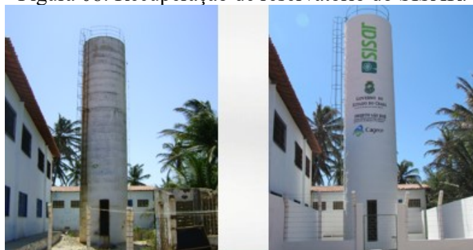
Figura 08: Recuperação de reservatório do SISAR.
