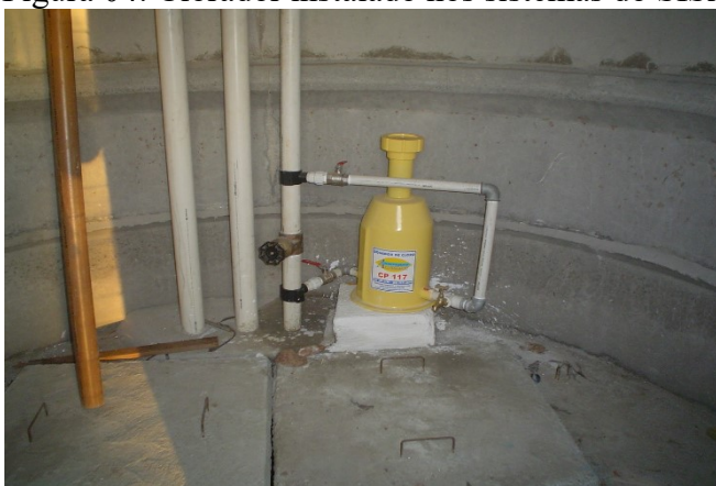
Figura 04: Clorador instalado nos sistemas do SISAR.
