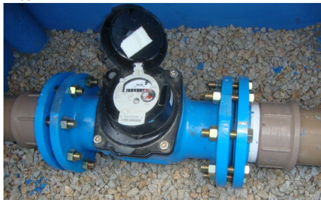
Figura 05: Macromedidor instalado nos sistemas do SISAR.
