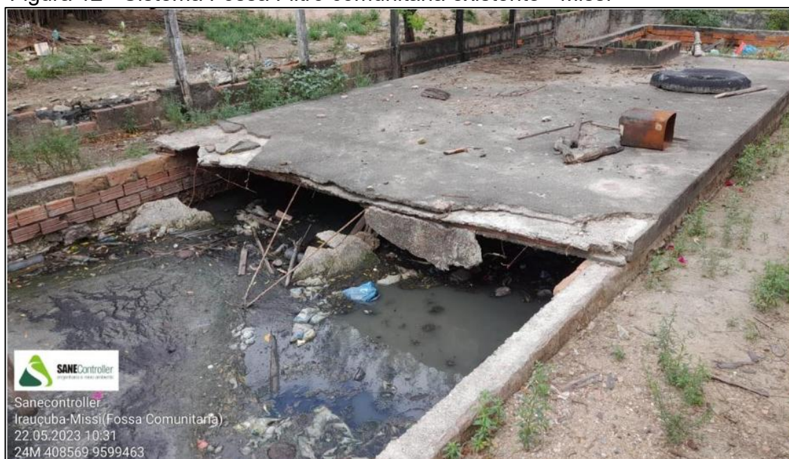
Figura 12 - Sistema Fossa Filtro comunitária existente - Missí
