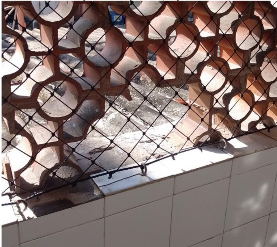
Figura 28 - Cobogó de vedação quebrado
