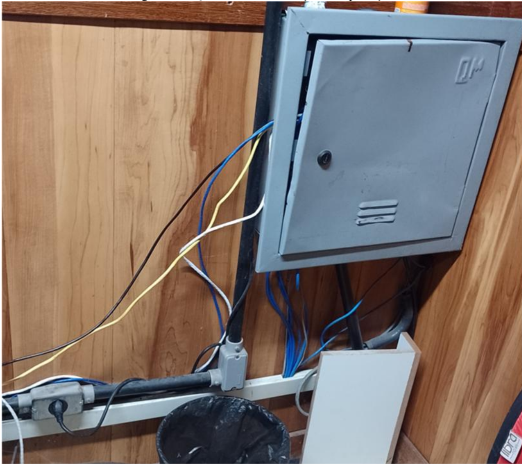
Figura 11 - Quadro elétrico e fiação sem proteção
