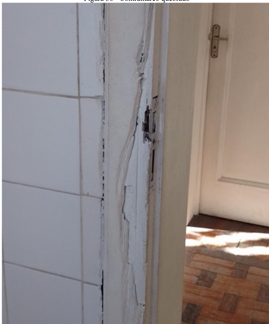
Figura 30 - Contramarco quebrado
