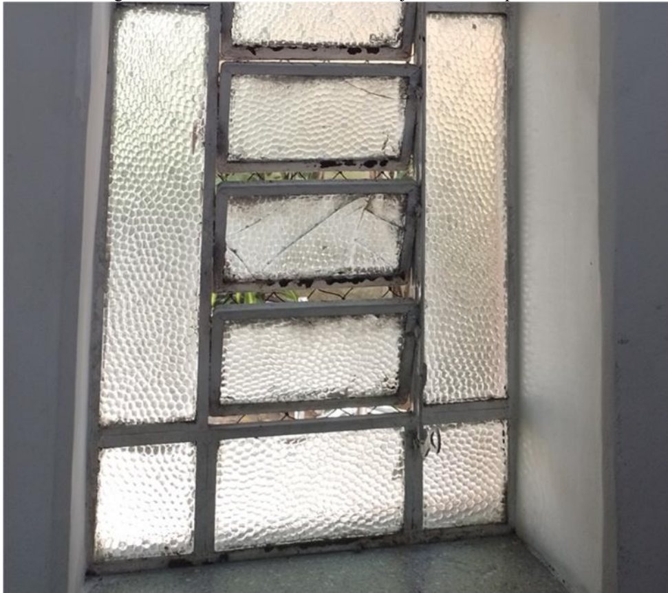
Figura 34- Janela com basculante enferrujada e vidros quebrados
