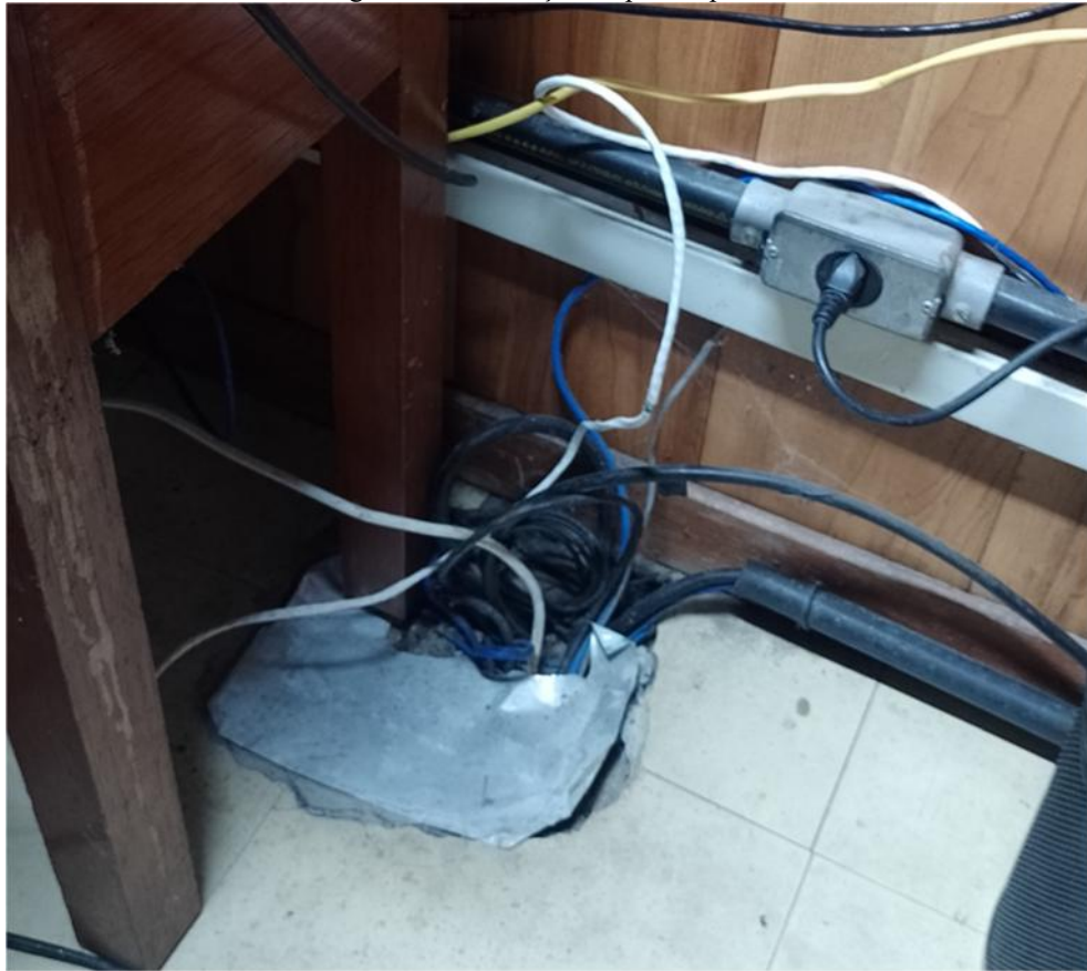
Figura 12 - Instalação de piso exposta
