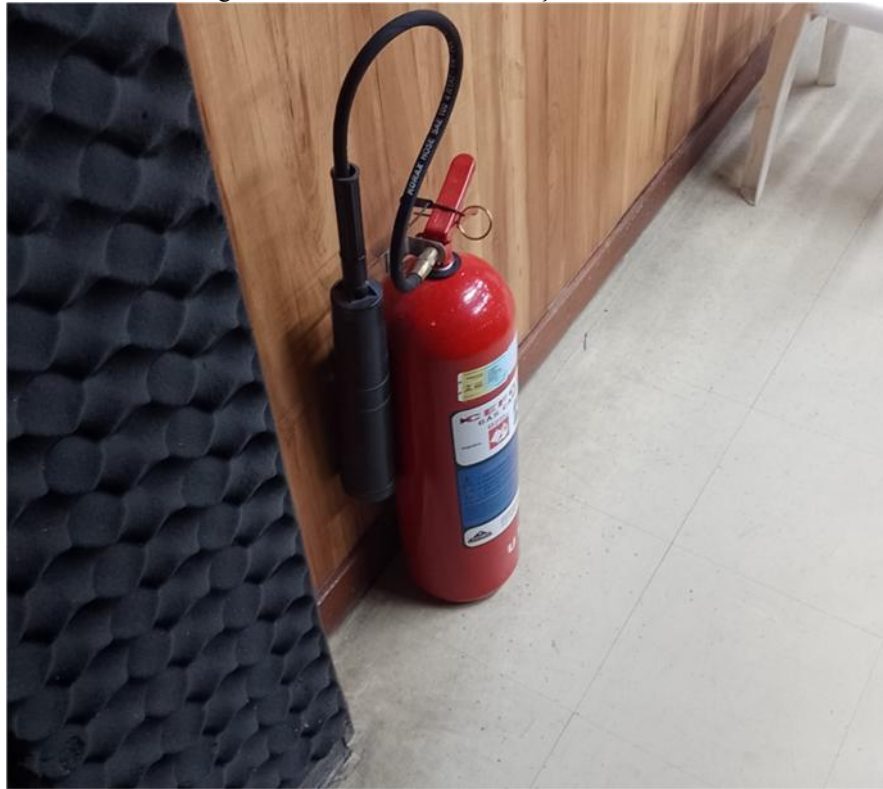
Figura 16 - Ausência de sinalização do extintor
