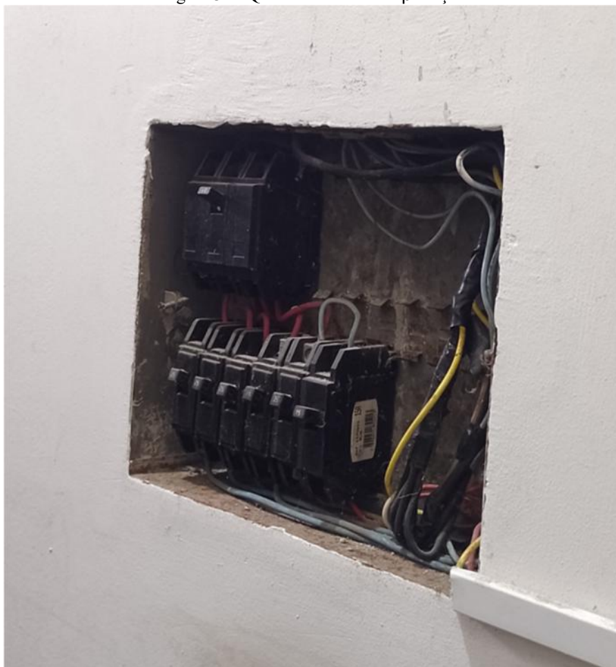
Figura 32 - Quadro elétrico sem proteção
