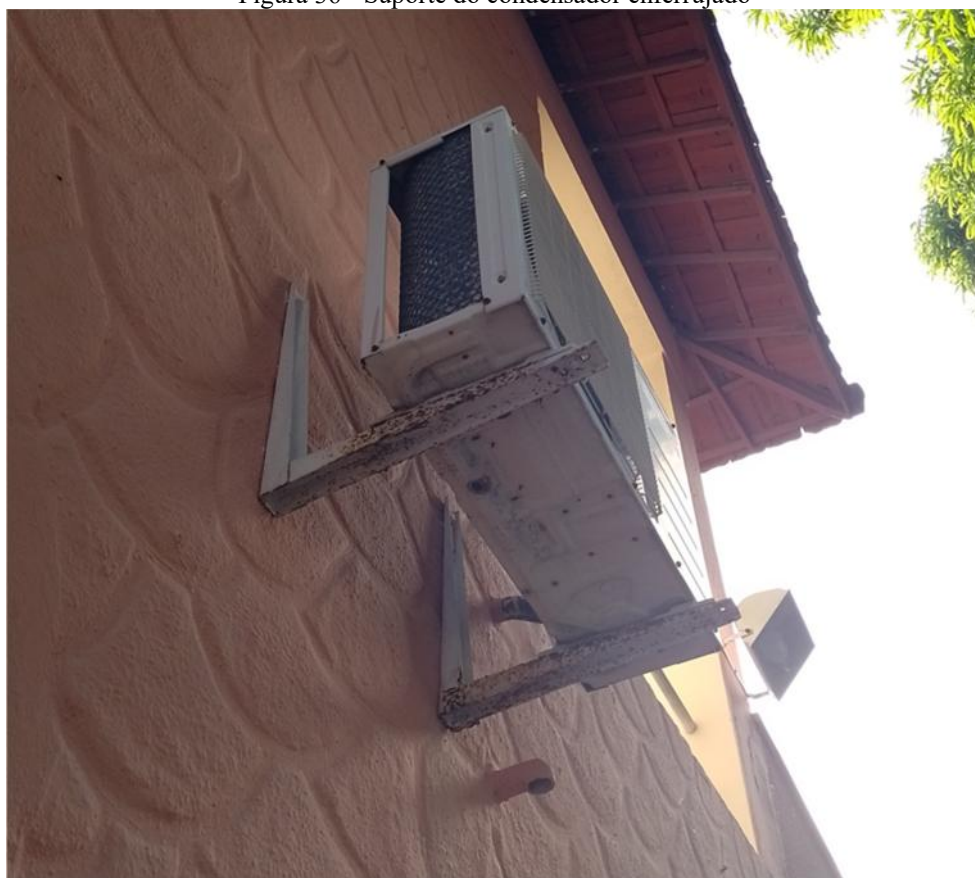
Figura 36 - Suporte do condensador enferrujado
