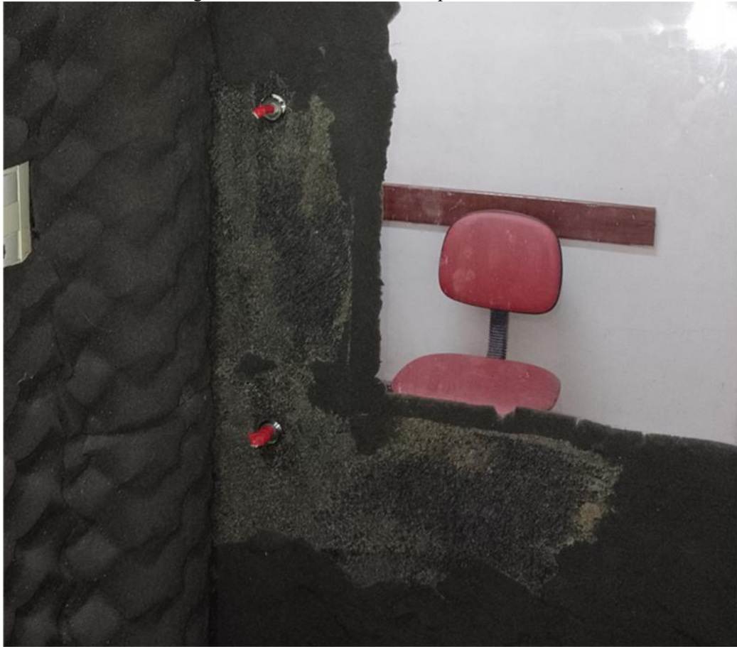
Figura 10 - Acesso sem trinco e espuma danificada
