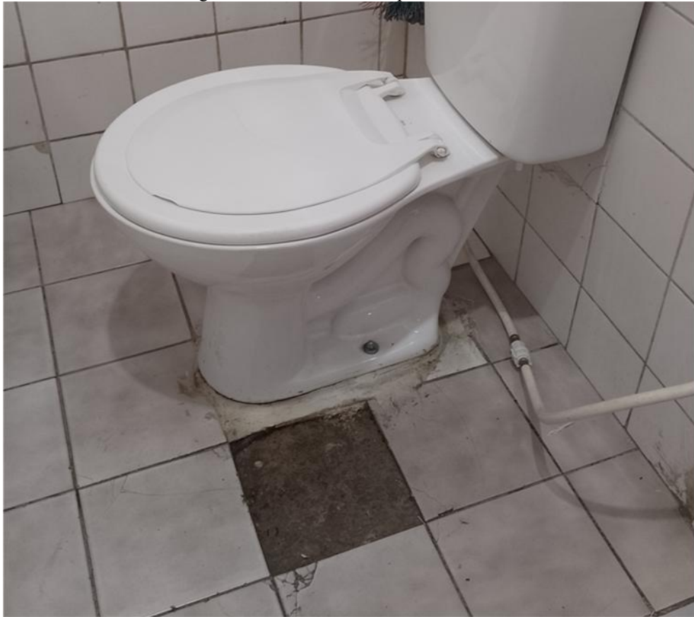
Figura 9 - Descolamento de placas cerâmica
