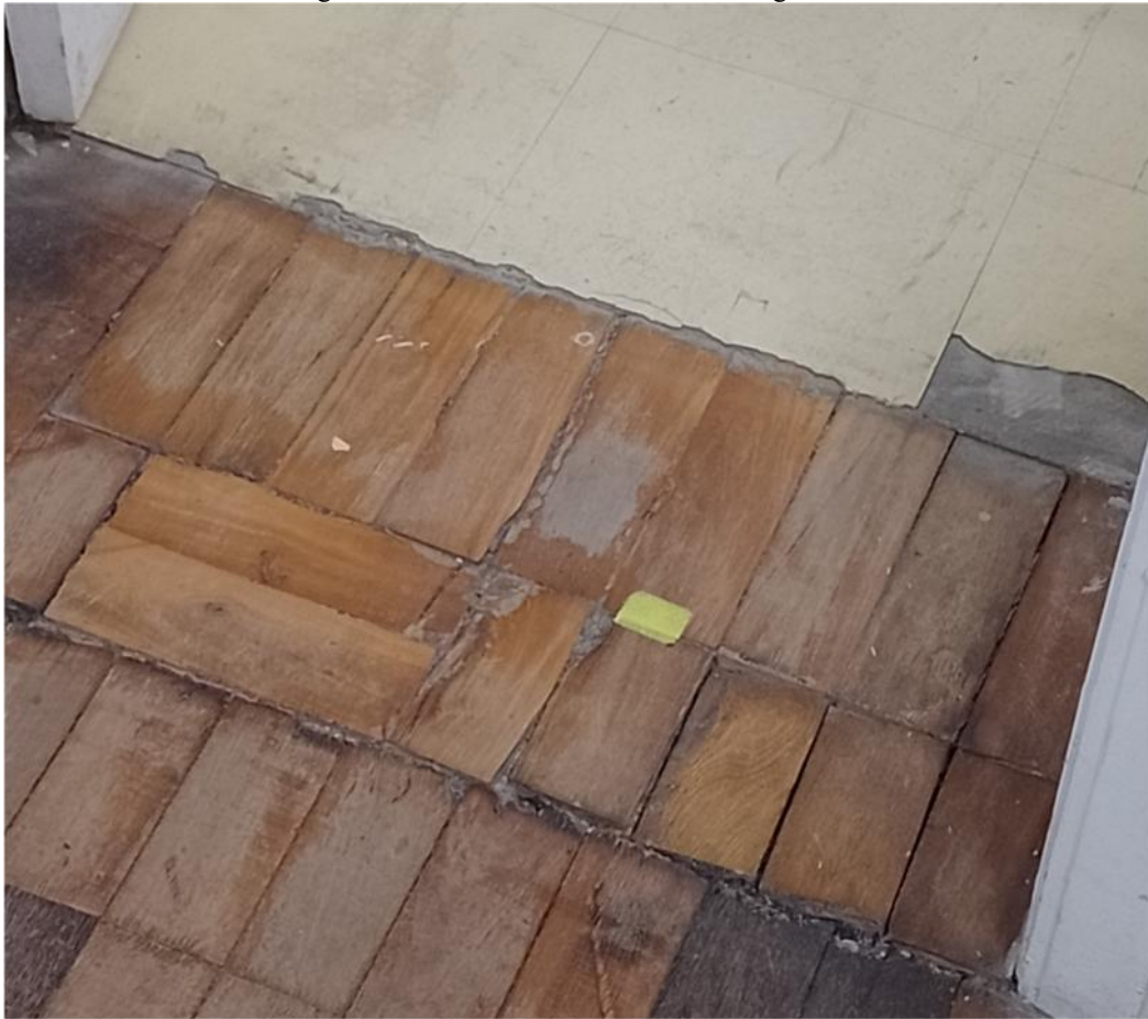
Figura 8 - Piso cerâmico e de madeira desgastado
