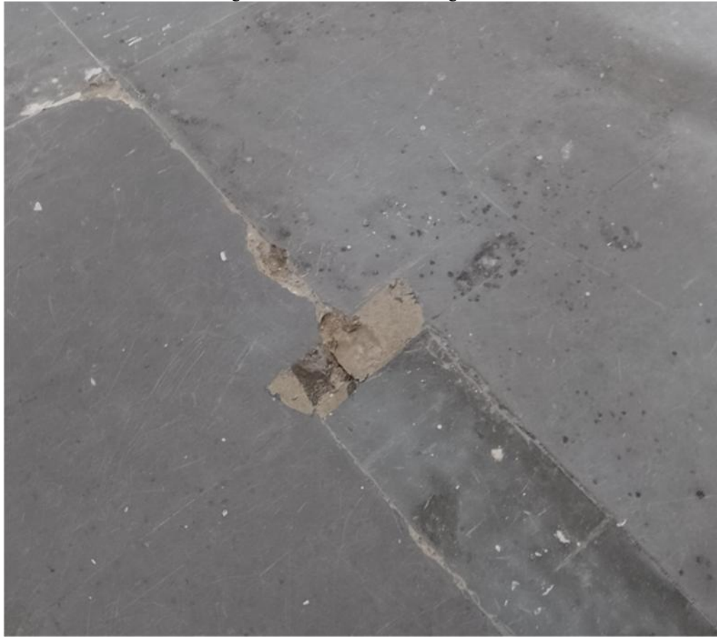
Figura 21 - Piso industrial desgastado
