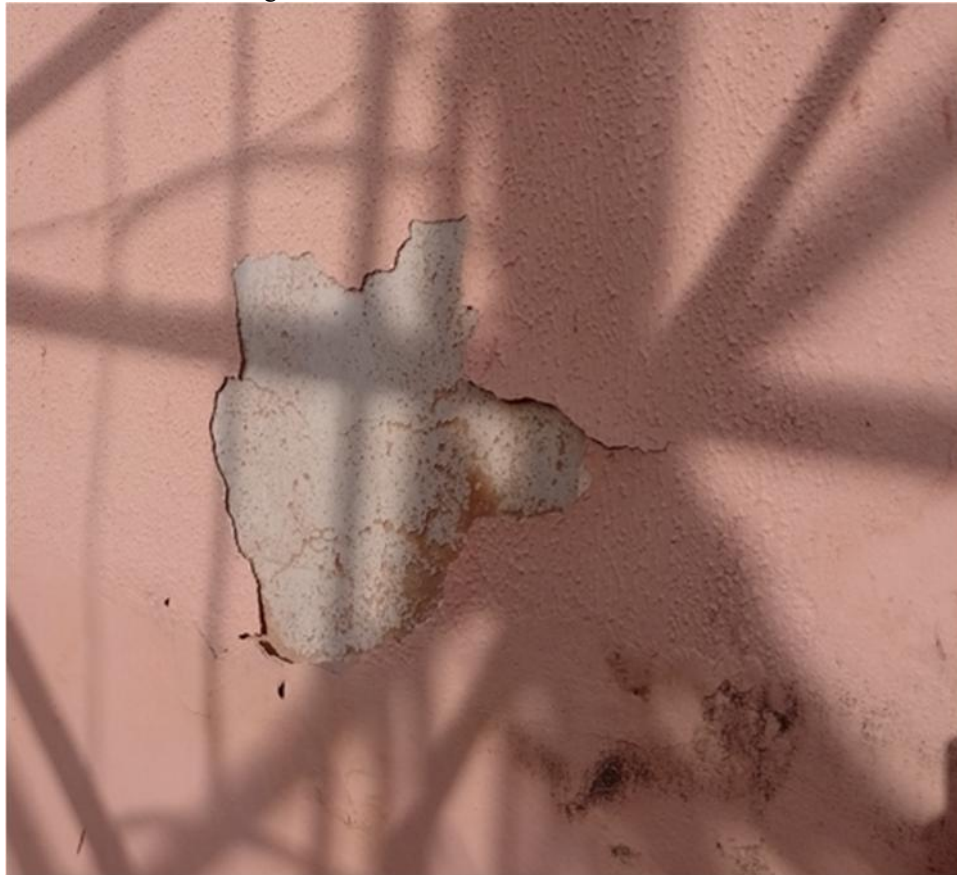
Figura 38 - Revestimento externo descascado
