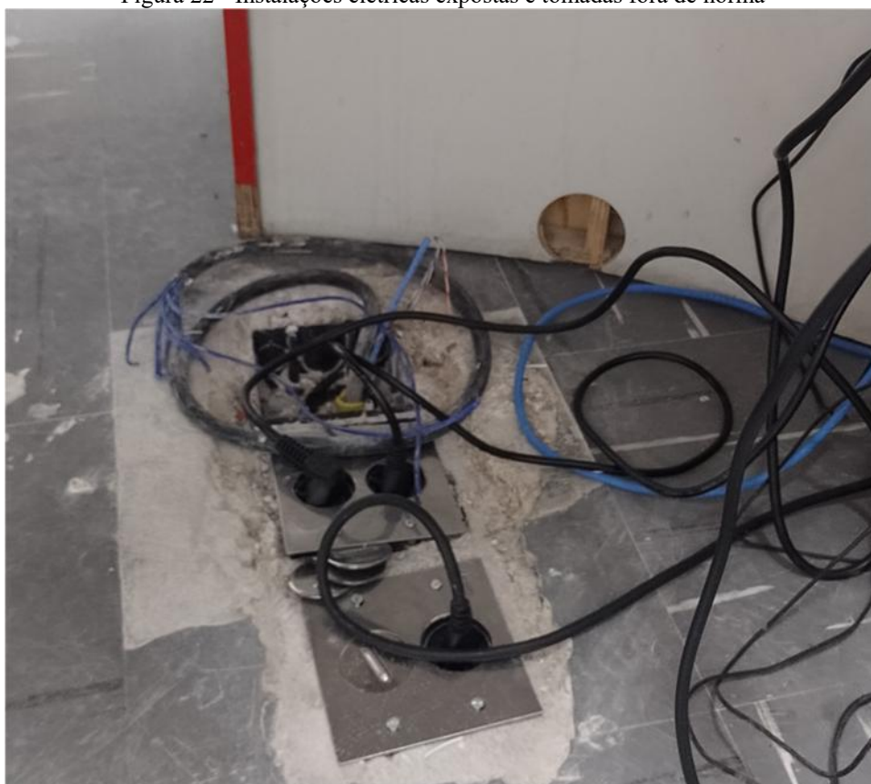
Figura 22 - Instalações elétricas expostas e tomadas fora de norma
