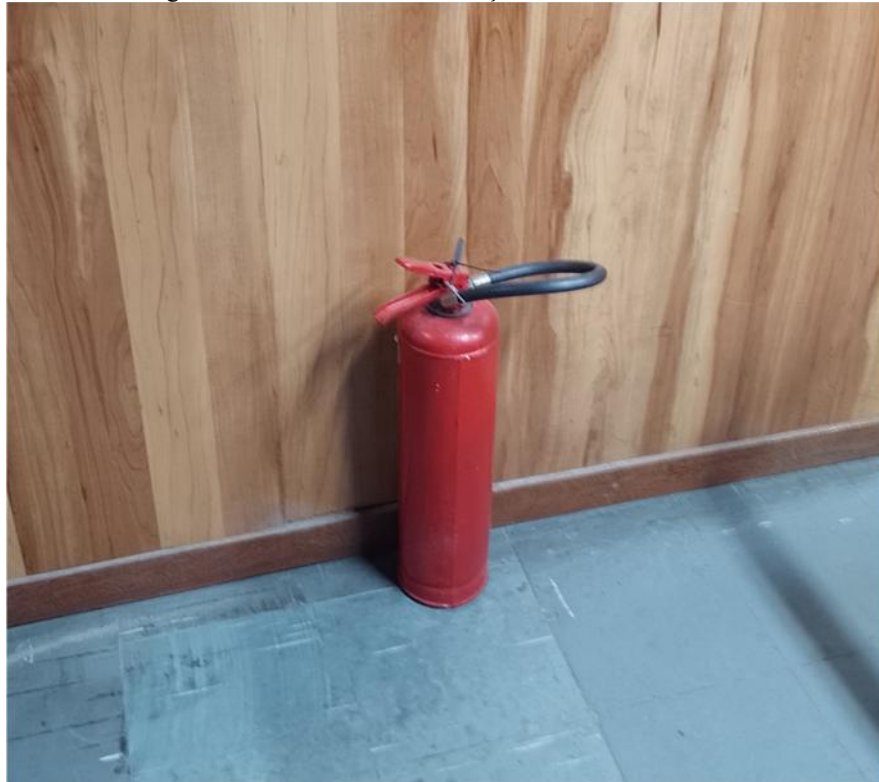
Figura 17 - Ausência de sinalização do extintor e difusor
