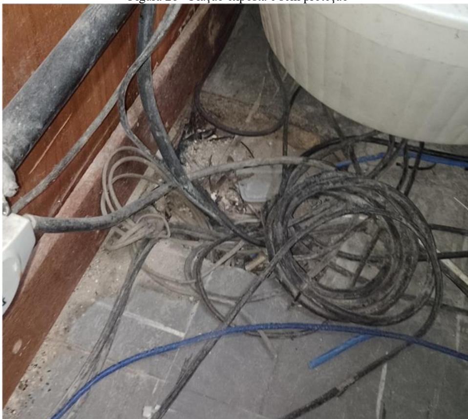
Figura 20 - Fiação exposta e sem proteção
