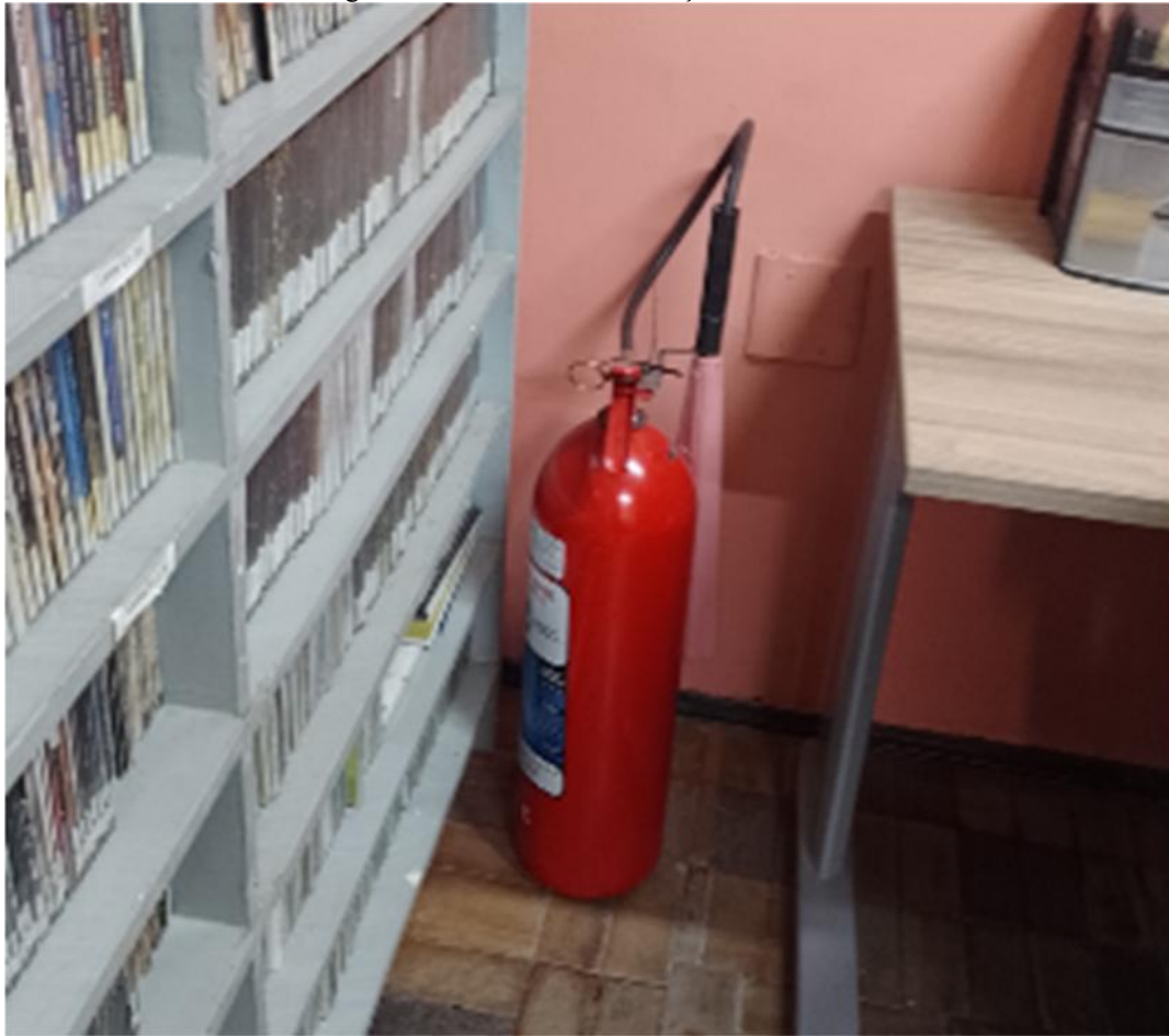
Figura 7 - Ausência de sinalização do extintor
