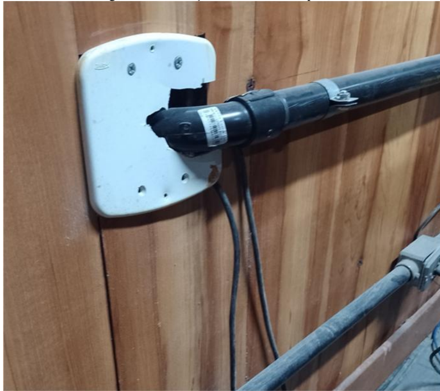
Figura 18 - Instalação elétrica fora dos padrões
