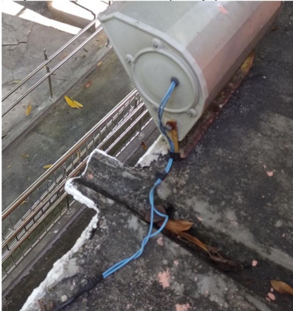
Figura 33 - Instalação elétrica sem eletroduto e queda da água pluvial sobre escada
