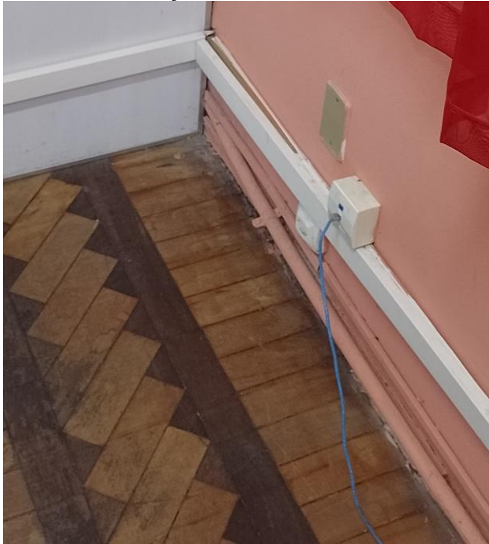
Figura 3 - Canaleta mal instalada
