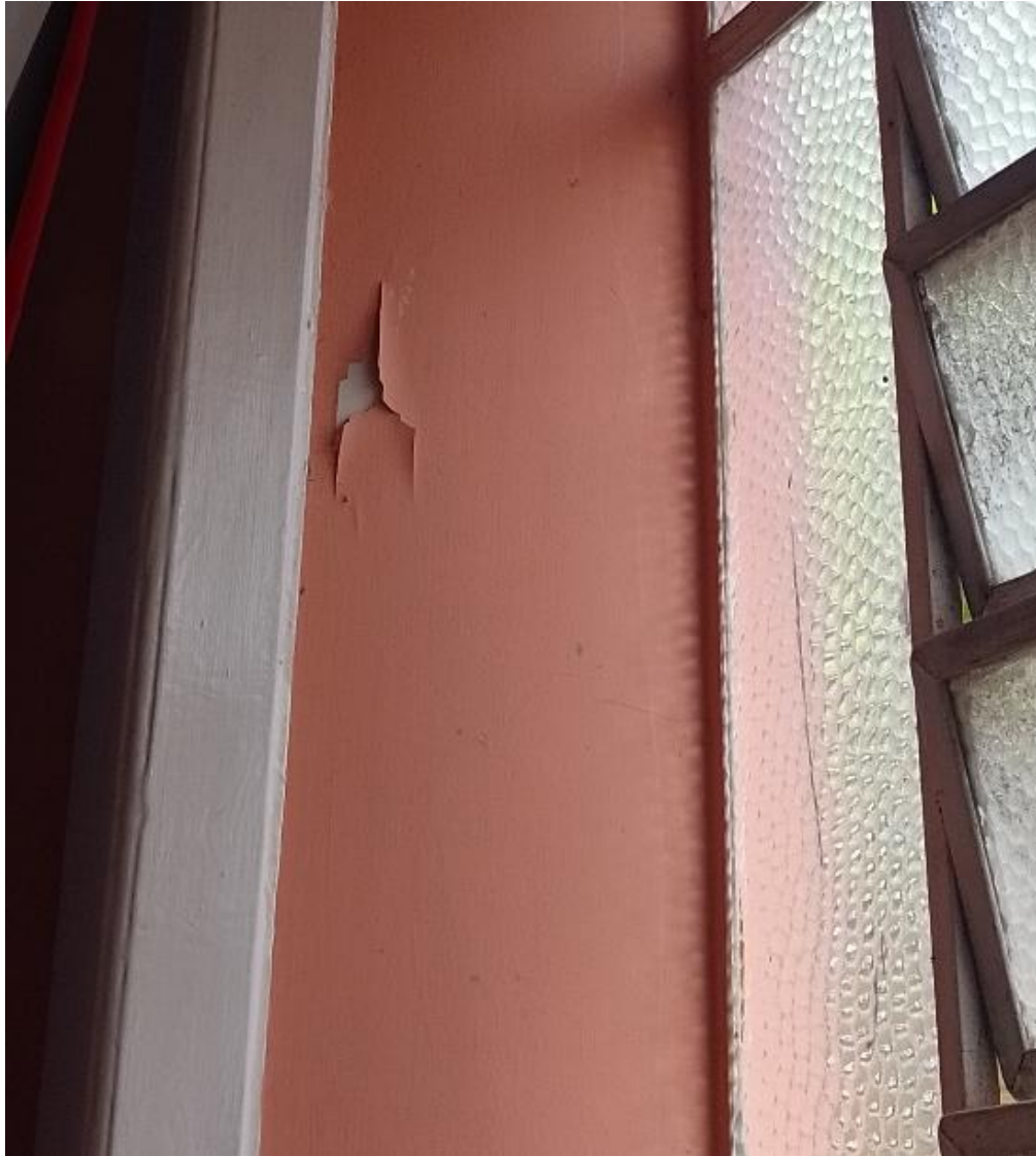
Figura 4 - Parede com Pintura desgastada
