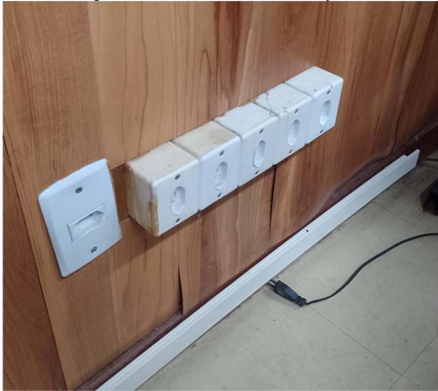
Figura 15 - Descolamento do revestimento de parede
