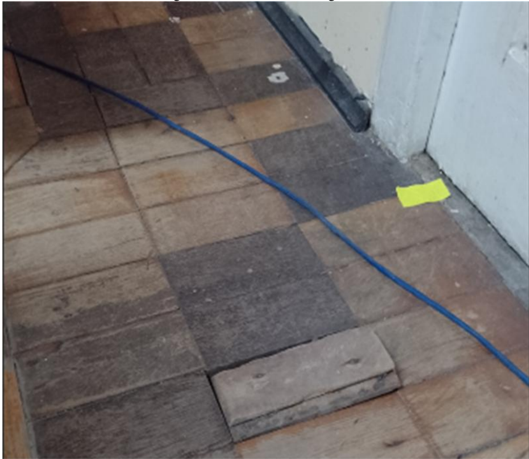
Figura 6 - Piso de madeira desgastado
