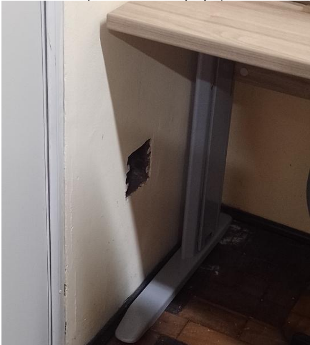
Figura 5 - Caixa elétrica sem tampa de proteção
