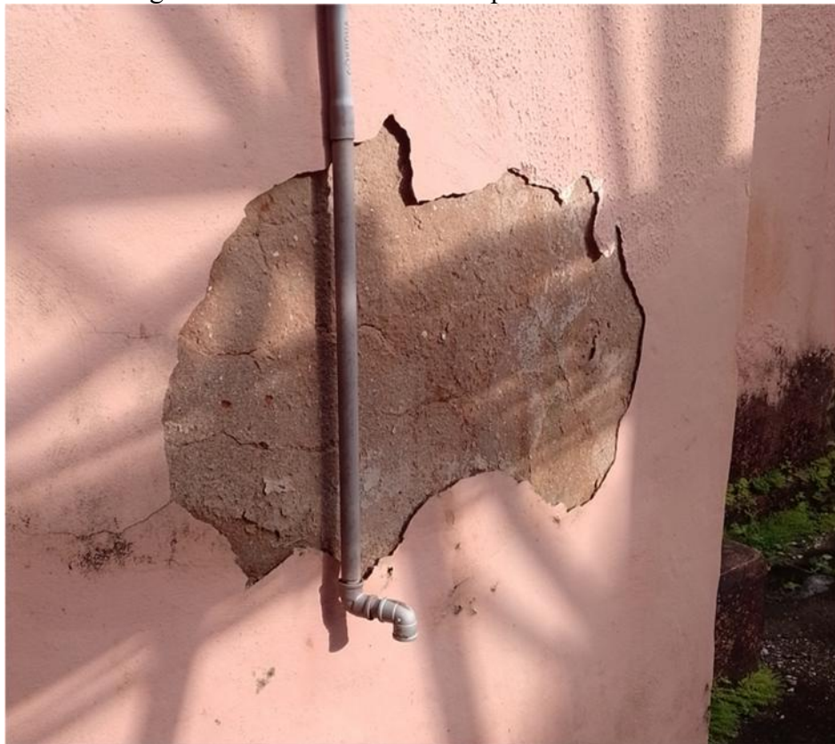
Figura 39 - Parede externa com pintura descascando
