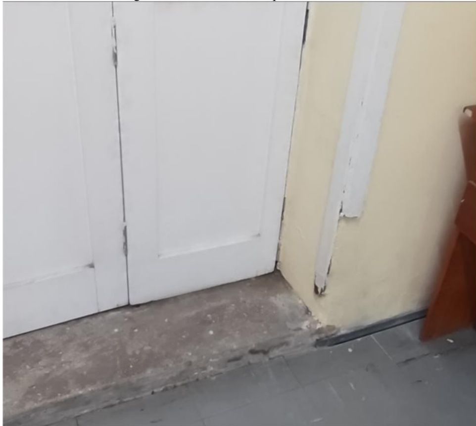
Figura 26 - Contramarco da porta danificado
