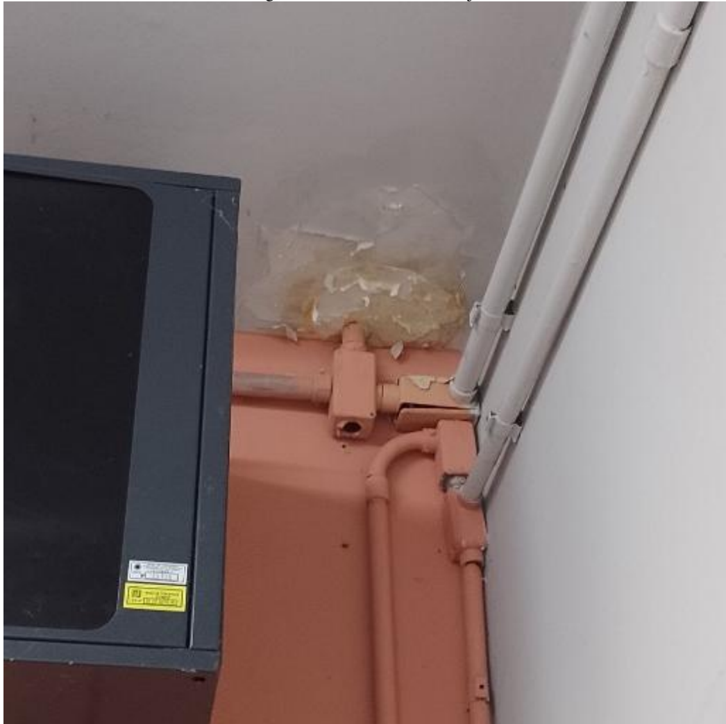
Figura 2 - Eflorescência na laje
