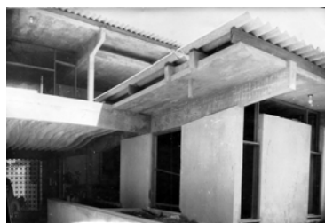
137-138. Gerhard Bormann. Fotos da construção. Residência Maria Olímpia Xavier, 1969. Fonte: Arquivo Nícia Bormann.
