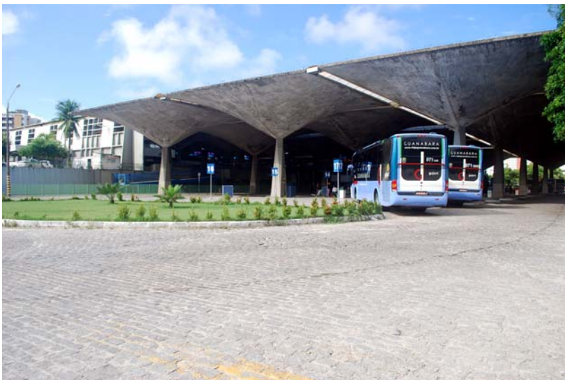
20. Luciano Marrocos Aragão. Terminal Rodov. João Thomé, 1969. Fachada sudoeste. Foto do autor.
