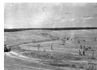
76. Serviços de terraplanagem do Estádio Plácido Castelo. Fortaleza, 1970. Fonte: Arquivo Nícia Bormann.
