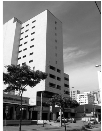
156. Edifício comercial atualmente inserido no antigo lote da residência Ronaldo Mont`Alvern
