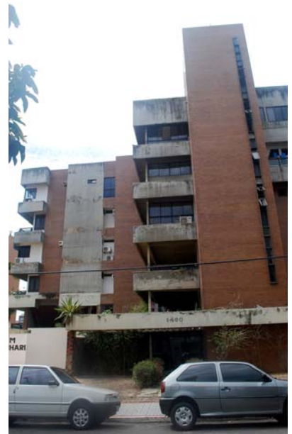
93-94. Regis Freire. Ed. Isaac Pontes, 1978. Fachadas oeste e norte. Fotos do autor.
