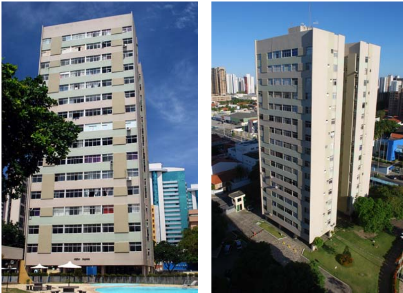
85-86. Joaquim Rodrigues. Edifícios Bagatelle e Demoiselle, 1976. Vista sudoeste edifício Bagatelle. Vista nordeste/noroeste edifício Demoiselle. Fotos do autor.
