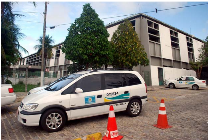
22. Luciano Marrocos Aragão. Terminal Rodov. João Thomé, 1969. Fachadas noroeste e sudoeste. Foto do autor.
