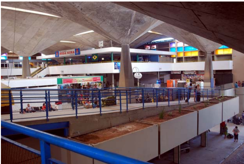
26. Luciano Marrocos Aragão. Terminal Rodov. João Thomé, 1969. Vista parcial dos três níveis. Foto do autor.
