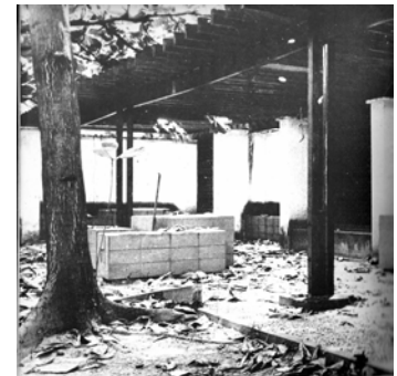
1. Gerhard Bormann. Jardim da Biblioteca. Fortaleza, 1966. Fonte: Arquivo UFC.
