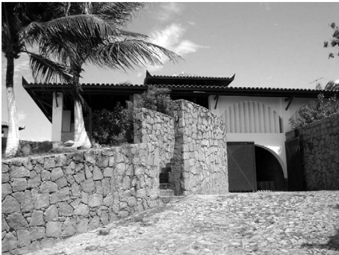
159. Fachada norte / acesso.
