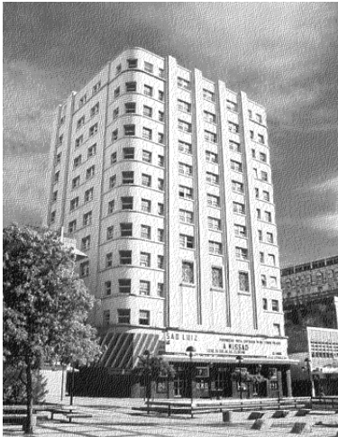
6. Humberto Justa Menescal. Cine São Luís. Construção: 1939-58. Fonte: Cals, 2002.
