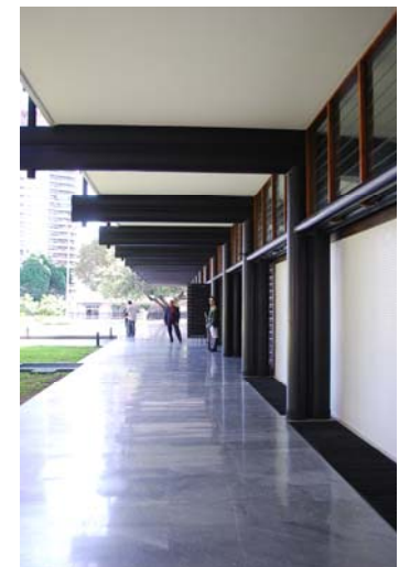
34. Sérgio Bernardes. Palácio da Abolição, 1970. Detalhe da fachada nordeste. Foto do autor.
