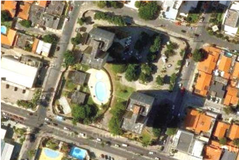
81. Joaquim Rodrigues. Edifícios Bagatelle e Demoiselle, 1976. Vista aérea. Fonte: Google Earth.
