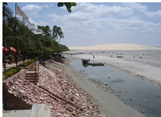
Figura 9 - Edificações sobre setores de domínio das marés, utilizando muros de contenção para diminuir a erosão (ação direta das ondas) durante a maré cheia.
