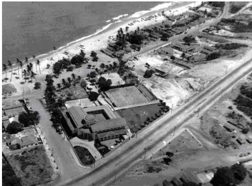
Figura 1.45. Vista aérea do Clube Náutico Atlético Cearense na década de 1950. Em primeiro plano a Av. Aquidabã, via de ligação com o novo porto no Mucuripe. Ao fundo a ocupação da faixa de praia por casas de pescadores. Fonte: FREITAS, 2005.
