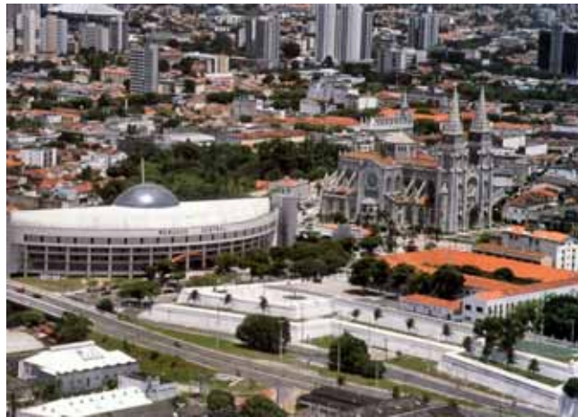
Figura 2.55. Implantação do Mercado Central de Fortaleza. Em primeiro plano a antiga Fortaleza de Na. Sra. da Assunção. Ao lado a Catedral. Fonte: Barbosa, 2006.
