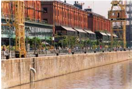
Figura 3.61. Vista dos galpões reformados em Puerto Madero . Fonte: www.puertomadero.com .
