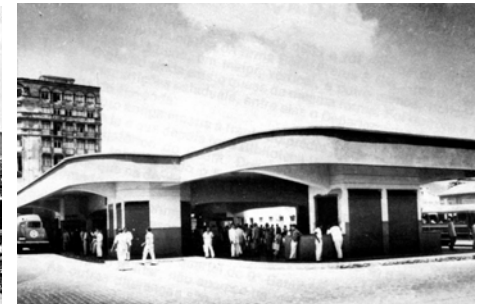
Figura 2.24. Praça do Ferreira em 1949 - Construído o Abrigo Central, misto de terminal de ônibus e centro comercial. Fonte: Acervo Nirez (Miguel Ângelo de Azevedo).
