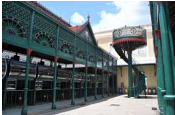
Figura 3.109. Interior do Mercado Francisco Bolonha (da carne) do complexo Ver-o-Peso. Os pavilhões em estrutura de ferro foram produzidos pela firma Walter Macfarlane & Co. Fonte: www.panoramio.com .
