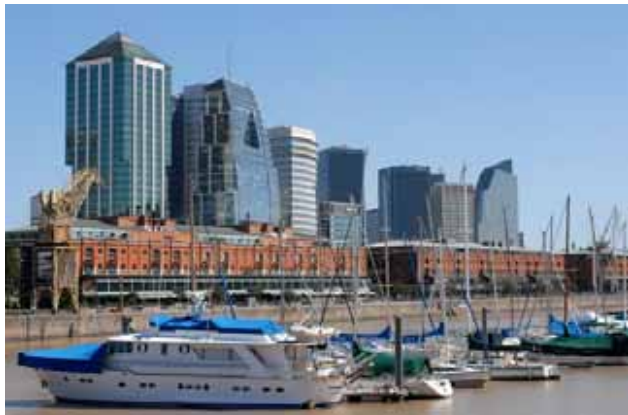
Figura 3.68. Vista de Puerto Madero . O diálogo entre os galpões recuperados e a arquitetura contemporânea. Fonte: www.puertomadero.com .
