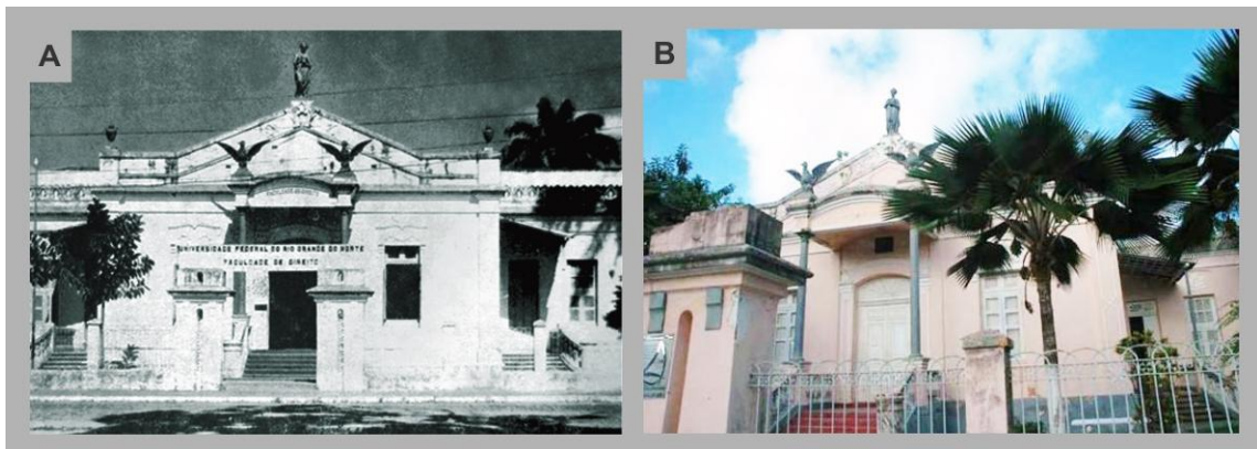
Figura 138:UFRN - Prédio da antiga Faculdade de Direito – (A) ano 1971 / (B) ano 2011. Localizado na Praça Augusto Severo, foi concebido pelo arquiteto mineiro Herculano Ramos (também autor da praça).
