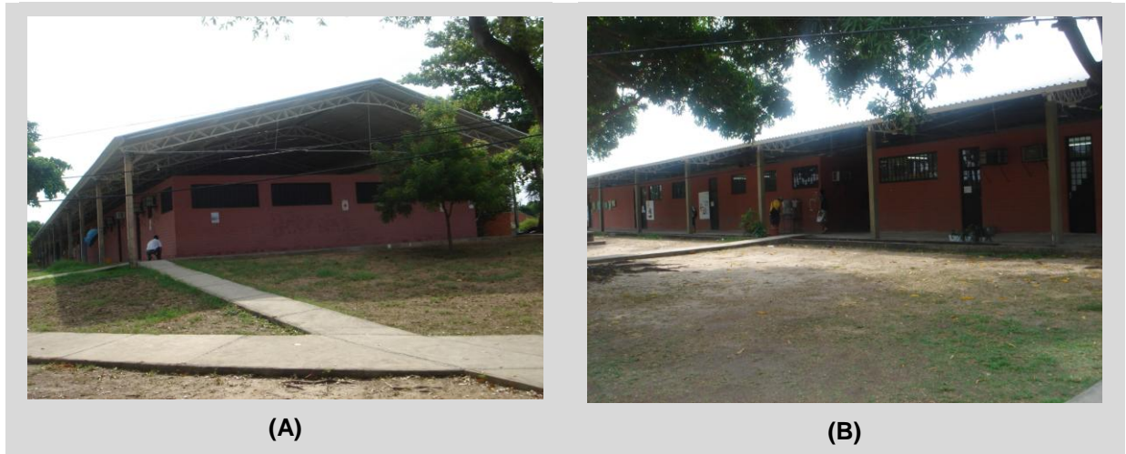
Figura 403: UFPI – Galpão do Setor de Serviços Gerais.
