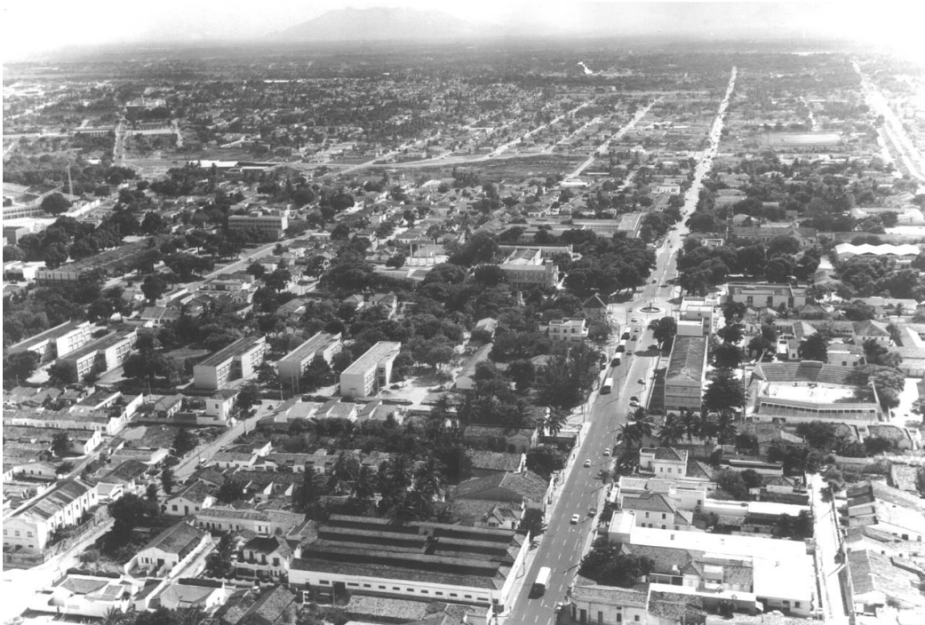
Figura 10: UFC – Vista do conjunto edificado do Benfica - 1971. A ocupação se deu ao longo da Avenida da Universidade – via de ligação norte / sul da cidade. À esquerda, destacam-se os blocos da Faculdade de Filosofia Ciências e Letras. (Fonte: Acervo COP / UFC)
