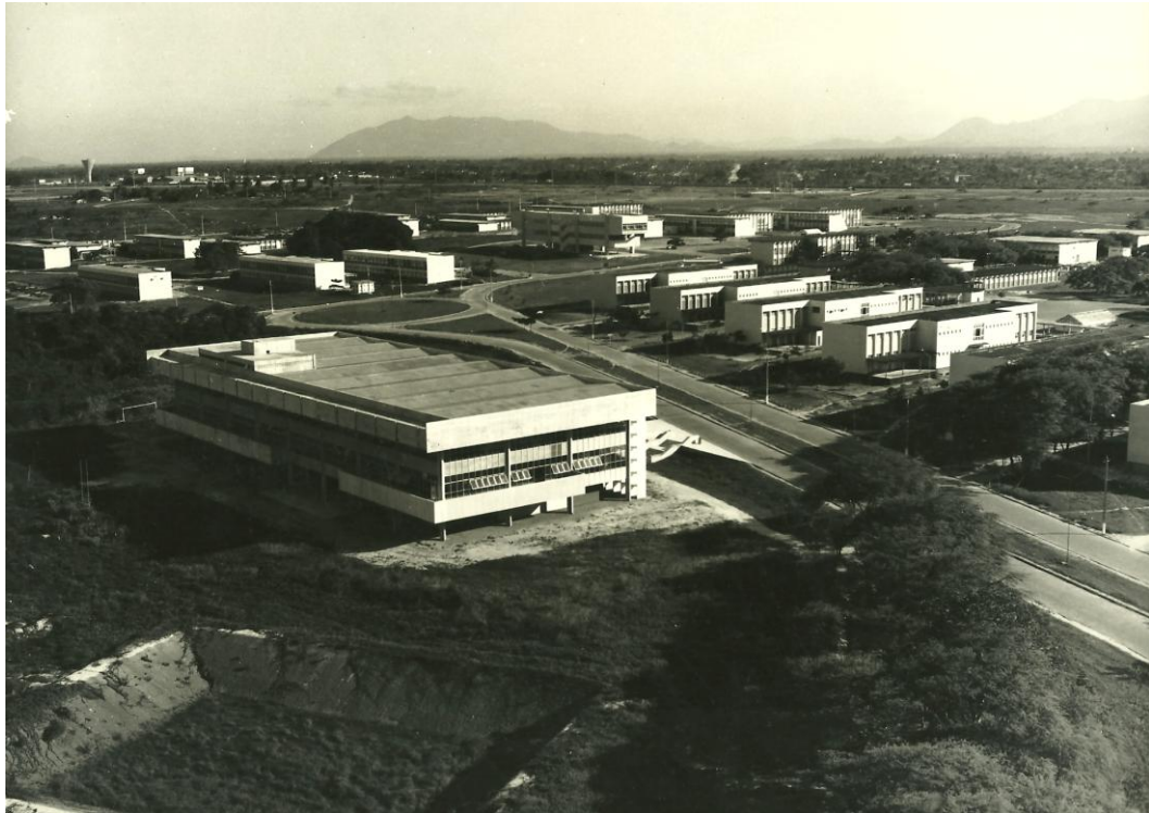
Figura 77: UFC – Biblioteca Central / vista das fachadas norte e leste - Década de 1970. A restrição na variedade dos materiais usados confere austeridade e homogeneidade à solução arquitetônica. (Fonte: Acervo COP / UFC)
