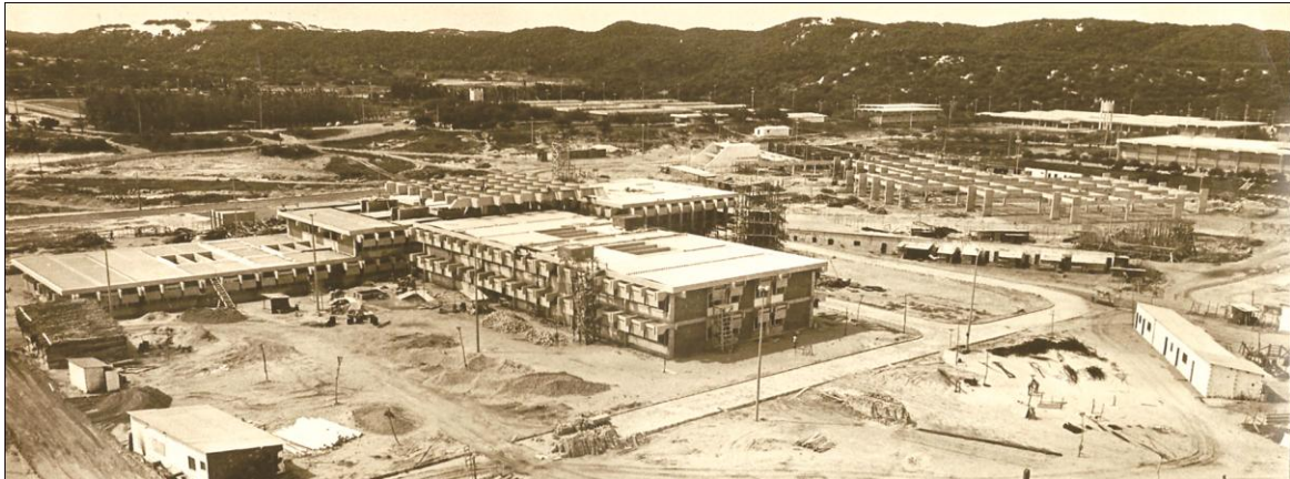
Figura 198: UFRN - Obras de construção do Campus Universitário. (Fonte: Acervo AGEKOM / UFRN)
