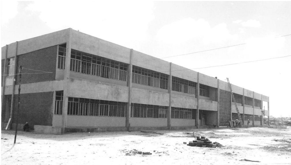
Figura 327: UFS - Vista do Bloco Didático Tipo 2 / fachada sul – segunda metade da década de 1970. Assim como na fachada norte, a superfície de combogó ameniza a linearidade da forma, e, ao mesmo tempo, atua como filtro solar. (Fonte: Arquivo Geral – Prefeitura do Campus )
