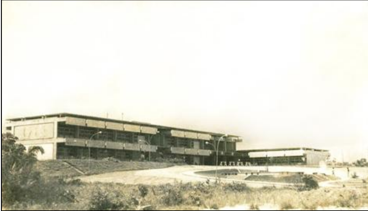
Figura 259: UFMA – Instituto de Ciências Físicas e Naturais – 1972. A praça hierarquiza o espaço, destacando a fachada principal do conjunto. (Fonte: Acervo Prefeitura do Campus )
