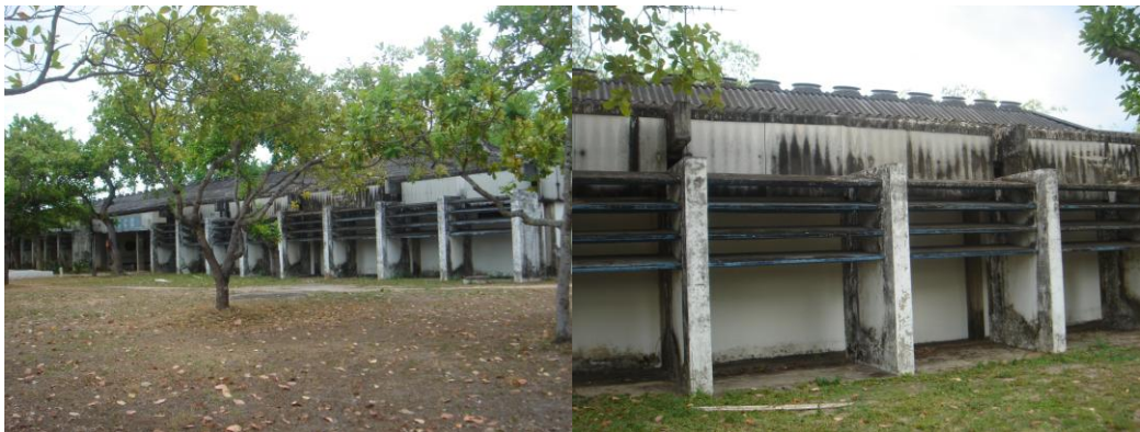
Figura 428: UFPI – Vista do edifício do CCE (2009).
