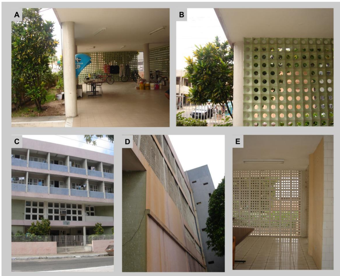
Figura 24: UFC – Residência Universitária – Ano 2008. (A) Vista dos piloti . (B) Detalhe do combogó cerâmico do piloti (C) Detalhe da fachada principal com as esquadrias de madeira e venezianas nas varandas. (D) Vista da cortina de combogó na fachada de fundo. (E) Vista da cortina de combogó no salão de jogos. (Fonte: Acervo Magda Campêlo, 2009)
