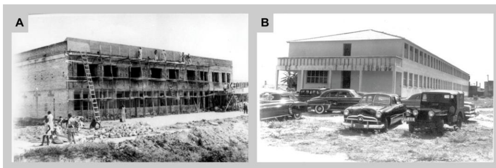
Figura 28: UFC - Hospital de Isolamento.
