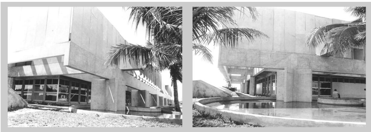
Figura 340: UFS – Detalhe da estrutura de concreto aparente - final década 1970. Os pilares externos em X e empenas com elementos de proteção solar. (Fonte: Arquivo Geral – Prefeitura do Campus ).
