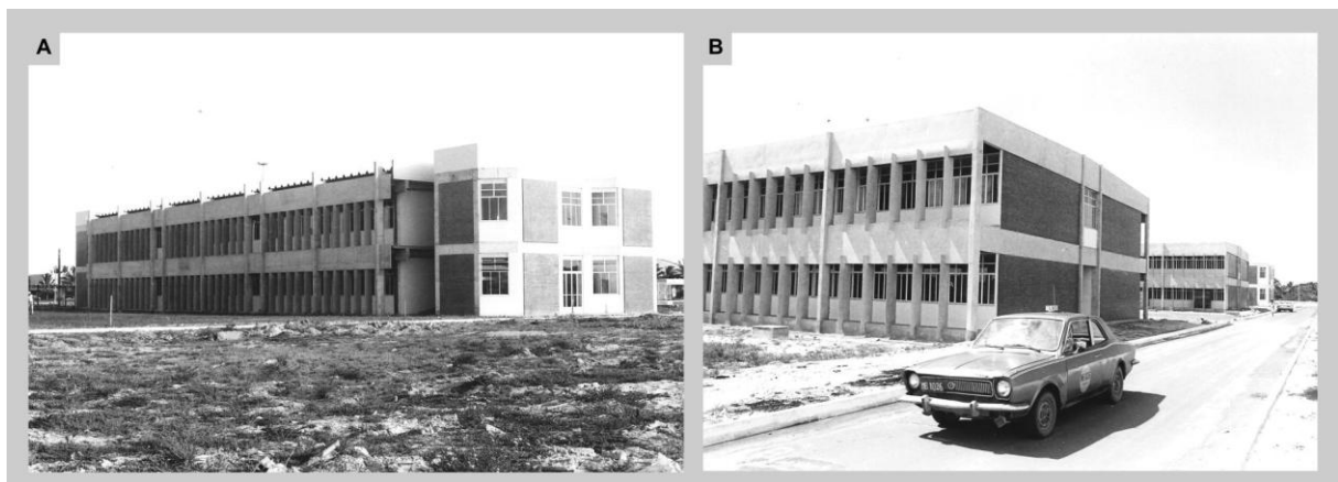
Figura 324: UFS - Vista do Bloco Didático Tipo 1 – segunda metade da década de 1970. (A) Detalhe da fachada sudoeste com os brises verticais em concreto aparente. (B) A via de veículos divide o conjunto didático da administração departamental e, ao mesmo tempo, articula o conjunto pavilhonar numa sequência de ordenação linear. (Fonte: Arquivo Geral – Prefeitura do Campus )
