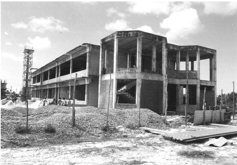
Figura 322: UFS - Execução do sistema estrutural da tipologia didática Tipo 1. A estrutura é independente com acabamento em concreto aparente (pilares, vigas e lajes). (Fonte: Arquivo Geral – Prefeitura do Campus )
