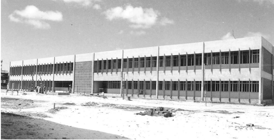
Figura 326: UFS - Bloco Didático Tipo 2/fachada norte – segunda metade da década de 1970. Os brises verticais e a superfície de combogó buscam o controle da radiação solar e participam como elemento de composição da forma arquitetônica. A estrutura trazida aos limites da edificação evidência o princípio da “verdade estrutural”. (Fonte: Arquivo Geral – Prefeitura do Campus )
