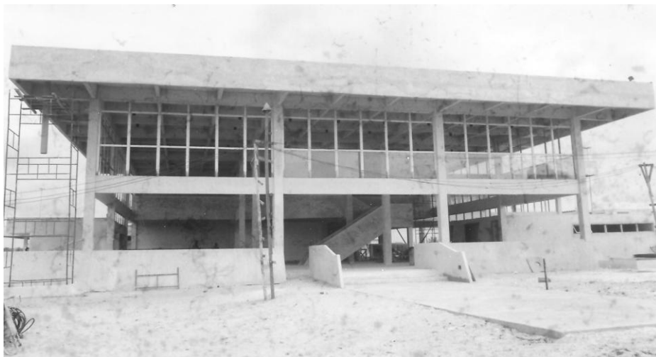
Figura 354: UFS – Restaurante (final década 1970, em fase execução). Destacam-se os elementos estruturais do edifício em concreto aparente e as superfícies envidraçadas recuadas da platibanda. (Fonte: Arquivo Geral – Prefeitura do Campus ).
