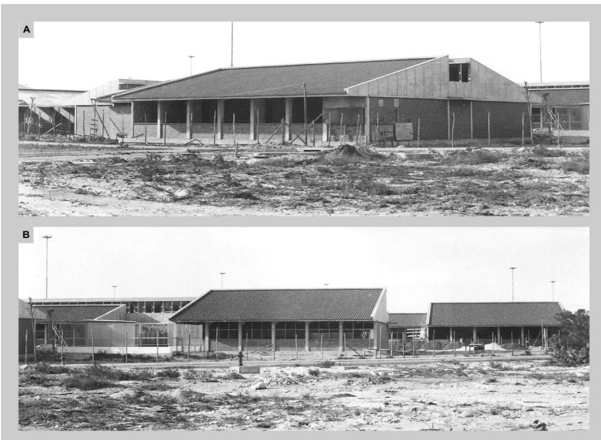
Figura 363: UFS - Centro de Ciências Biológicas e da Saúde e Centro de Ciências Exatas e Tecnológicas (meados da década de 1980). (A) Bloco padrão em construção: cobertura em telha cerâmica e empena em placas de cimento pré-moldadas. (B) A modulação construtiva permite a padronização das esquadrias e destaca os pilares separados dos panos de vedação - alvenarias e esquadrias. (Fonte: Arquivo Geral – Prefeitura do Campus ).
