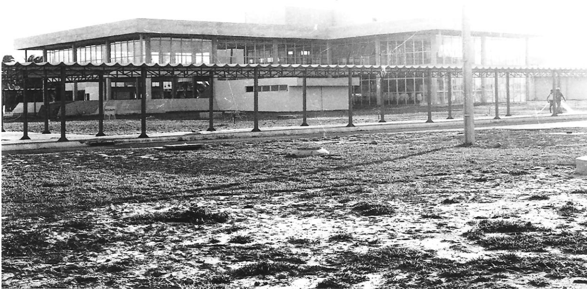
Figura 356: UFS – Restaurante (década de 1980). A passarela coberta (primeiro plano) articula o Restaurante com as edificações do entorno. As áreas envidraçadas permitem a incidência solar direta no interior dos ambientes. (Fonte: Arquivo Geral – Prefeitura do Campus ).
