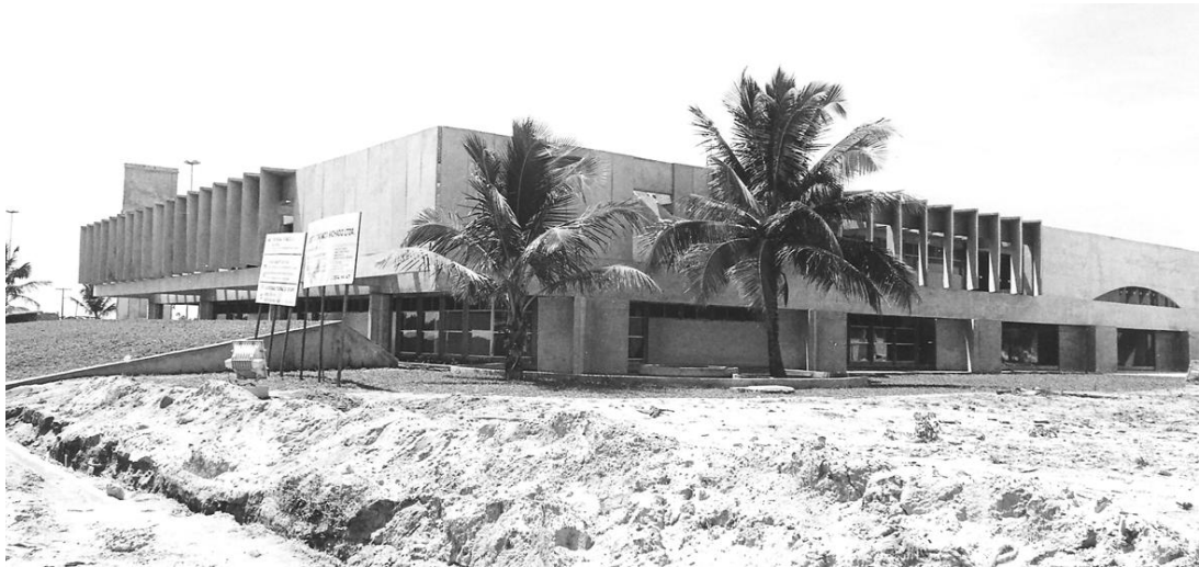
Figura 338: UFS – Vista do Bloco da Biblioteca em fase de finalização da obra - final década de 1970. No primeiro plano: a volumetria principal, que utiliza a linguagem do concreto aparente na forma de caixa fechada, sendo atenuada pelos elementos que funcionam como dispositivos de proteção solar. À esquerda, segundo plano: o volume da caixa d'água que compõe o conjunto contrapõe a horizontalidade da volumetria principal. (Fonte: Arquivo Geral – Prefeitura do Campus ).
