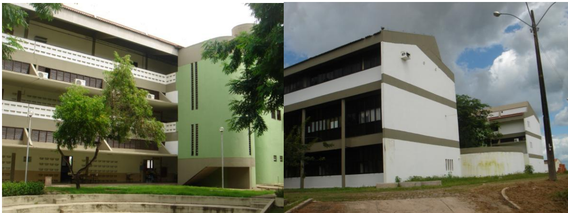
Figura 293: Centro de Ciências Exatas e Tecnológicas – 2009. Tipologia construtiva para o CCET com base nos estudos tipológicos do Plano. Atualmente encontra-se isolada por muros divisores. (Fonte: Acervo pessoal da autora)
