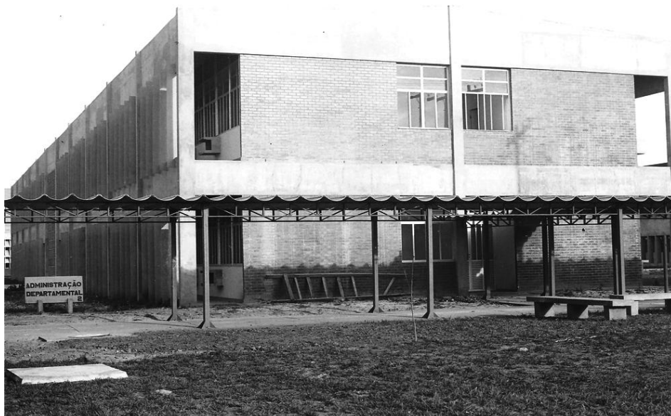
Figura 333: UFS – Bloco Departamental Tipo 1 - segunda metade da década de 1970. Vista da fachada leste. Destacam-se os panos de vedação em revestimento cerâmico da estrutura de concreto. O acesso ao edifício fica encoberto pela ausência de um elemento que marque sua presença. (Fonte: Arquivo Geral – Prefeitura do Campus ).
