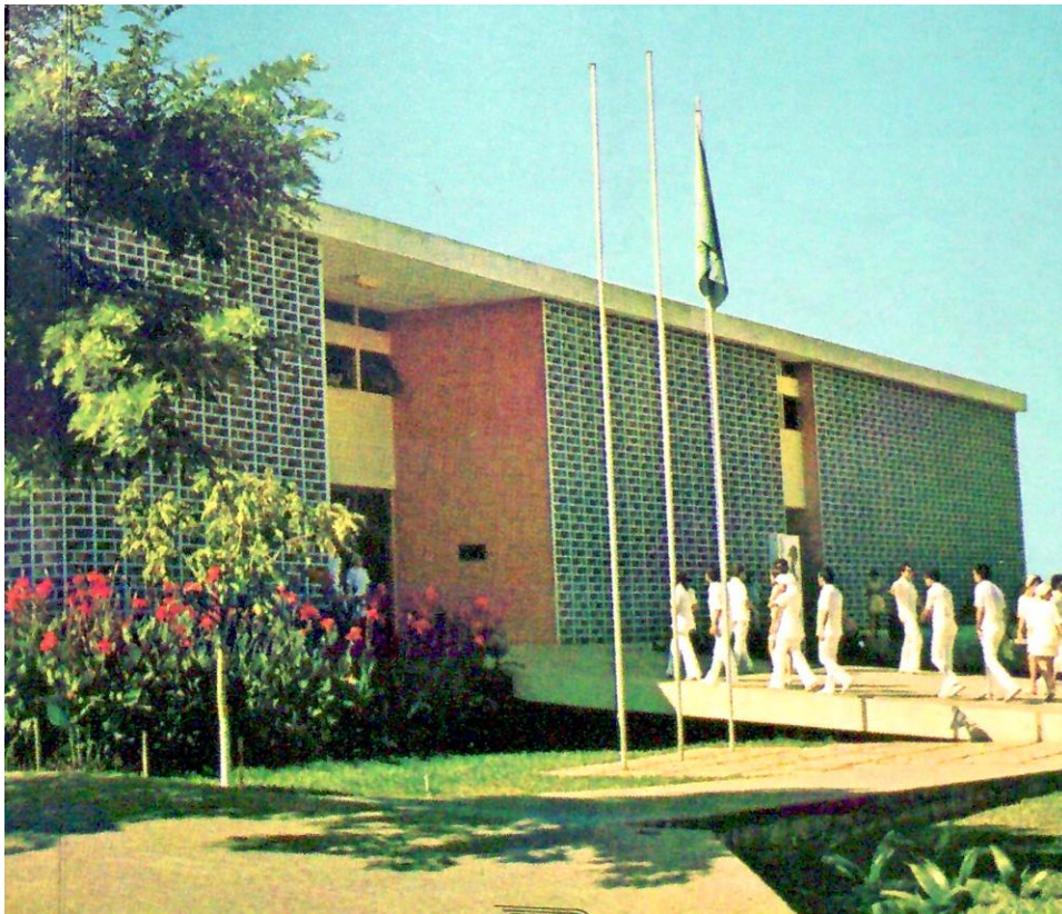
Figura 146:UFRN - Prédio da Faculdade de Odontologia –ano1966. A linha horizontal da laje de cobertura e os painéis de combogó conferem leveza e transparência à forma arquitetônica. (Fonte: GARCIA, 2008, capa, edição nossa).
