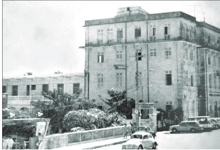
Figura 143: UFRN - Hospital Universitário Onofre Lopes, antigo Hospital Miguel Couto, depois Hospital das Clínicas – ano 1971. Localizado na Avenida Nilo Peçanha, sua arquitetura prenuncia as tendências protomodernas. (Fonte: LIMA e MELO, 1971 apud TRIGUEIRO)
