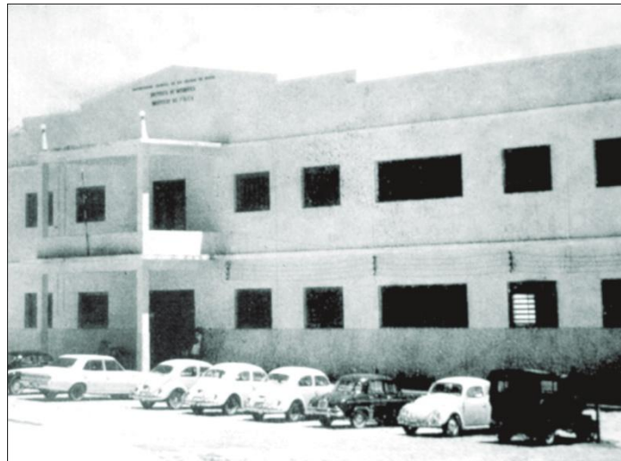
Figura 144:UFRN - Prédio da antiga Faculdade de Farmácia e Odontologia – Primeira metade da década de 1960. Localizado na Praça do Estudante, tem na sua forma arquitetônica a mescla de transição entre o ecletismo e o modernismo. O prédio abrigou posteriormente os Institutos de Física e Matemática (TRIGUEIRO, 2008, p. 54). (Fonte: LIMA e MELO, 1971 apud TRIGUEIRO, 2008, p. 54)
