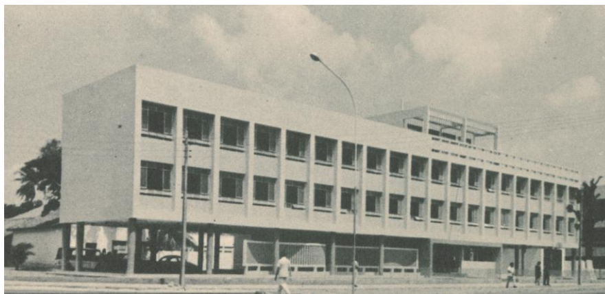
Figura 12: UFC - Escola de Engenharia – Década de 1960. Vista do edifício pela fachada principal voltada para a Avenida da Universidade. (Fonte: UFC, 1966, n.p.)
