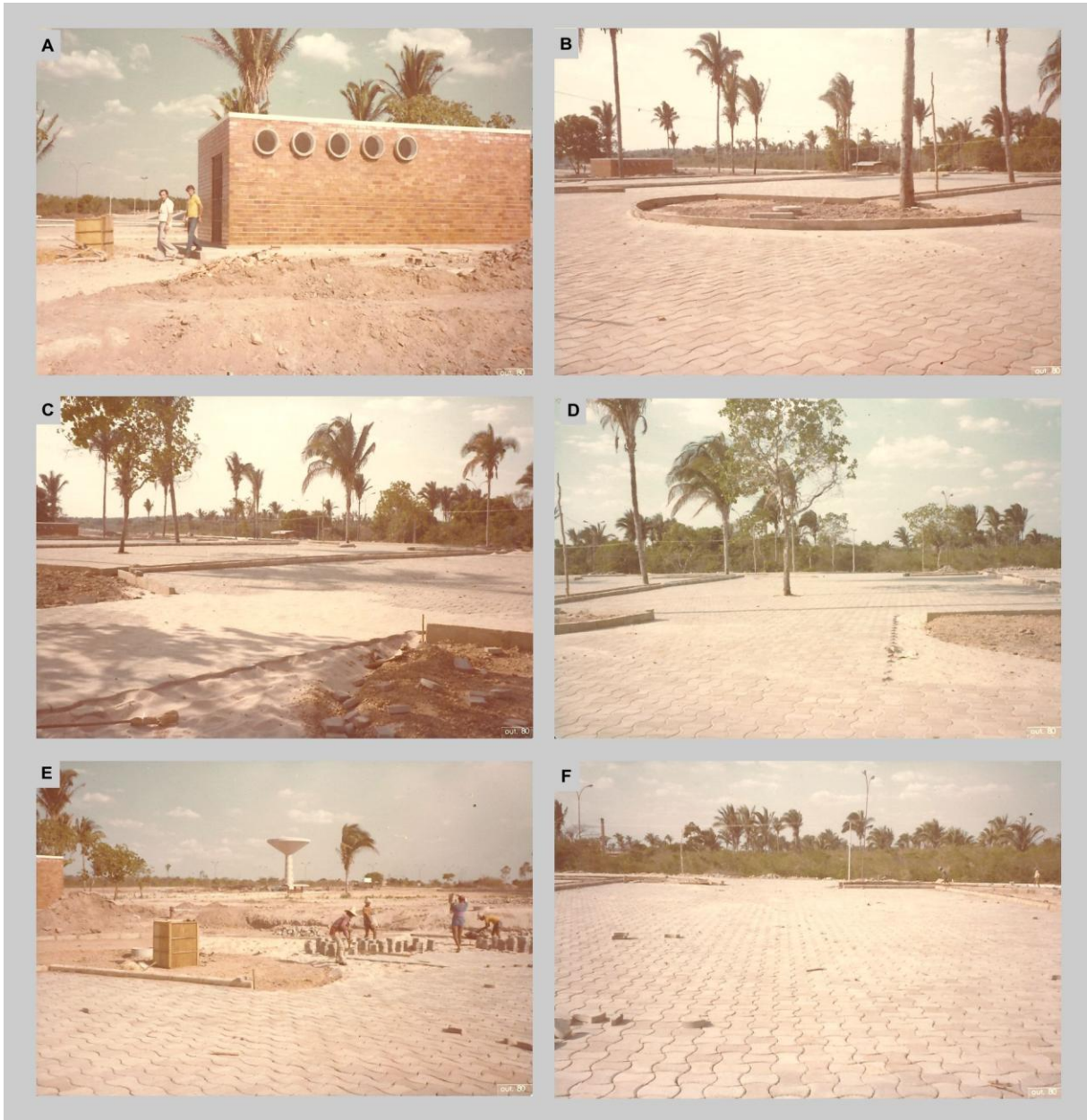
Figura 387: UFPI – Vista das obras de infraestrutura do campus – ano 1980.
