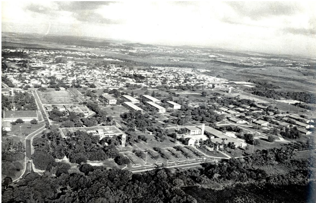
Figura 310: UFS – Vista Geral do Campus Universitário - década de 1980. Já estavam construídos: a Reitoria, a Biblioteca, o Restaurante, os Laboratórios do Centro de Tecnologia, Unidades Didáticas e Departamentais, Setor Esportivo e as obras de infraestrutura. Pode-se visualizar o sistema viário com anel circular periférico e bolsões de estacionamento. (Fonte: Acervo Assessoria de Comunicação - UFS)
