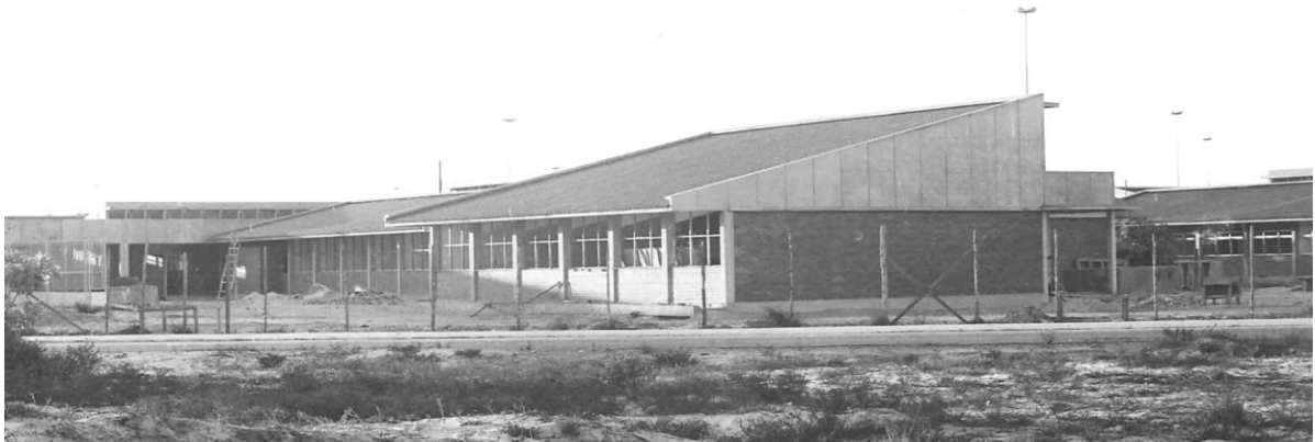
Figura 364: UFS - Centro de Ciências Biológicas e da Saúde e Centro de Ciências Exatas e Tecnológicas (meados da década de 1980). Modulação construtiva permite a padronização das esquadrias e destaca os pilares separados dos panos de vedação - alvenarias e esquadrias. (Fonte: Arquivo Geral – Prefeitura do Campus ).
