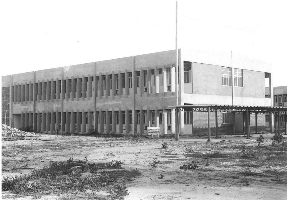
Figura 332: UFS – Bloco Departamental Tipo 1 - segunda metade da década de 1970. Vista da fachada norte que adota os brises verticais conjugados com a estrutura de concreto aparente, trazida para os limites da edificação. A composição atua como um filtro, criando uma película permeável que suaviza o impacto da forma prismática. (Fonte: Arquivo Geral – Prefeitura do Campus ).
