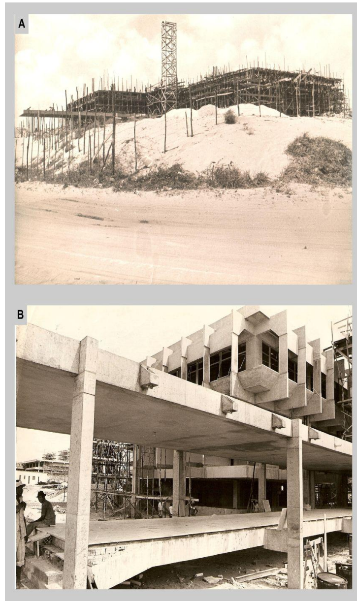
Figura 195: UFRN - Reitoria da UFRN – meados da década de 1970. (A) Detalhe da construção. A estrutura de concreto armado se destaca como elemento de composição plástica, garantindo a expressividade escultórica do edifício. (B) Execução da estrutura de concreto. (Fonte: Acervo AGEKOM / UFRN)
