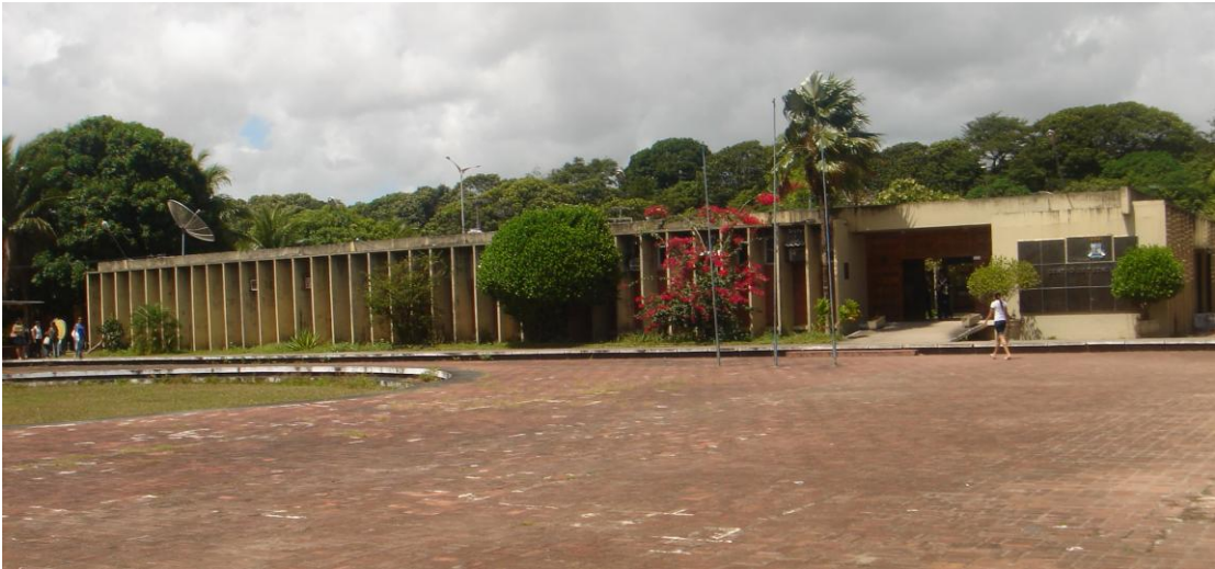
Figura 121: UFPB – Bloco Administrativo / Fachada principal. A estrutura originalmente destacava-se das vedações em concreto aparente. (Fonte: Acervo Magda Campêlo, 2009)
