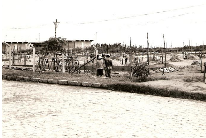
Figura 176: UFRN - Setor Didático-Administrativo – Canteiro de obras. (Fonte: Acervo AGEKOM / UFRN)
