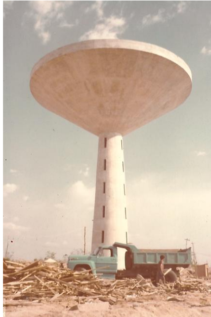
Figura 385: UFPI - Vista da caixa d'água, ano 1980. A volumetria em forma de cogumelo executada em concreto aparente. (Fonte: Acervo Pessoal Arquiteto Ronaldo Pinto Marques)
