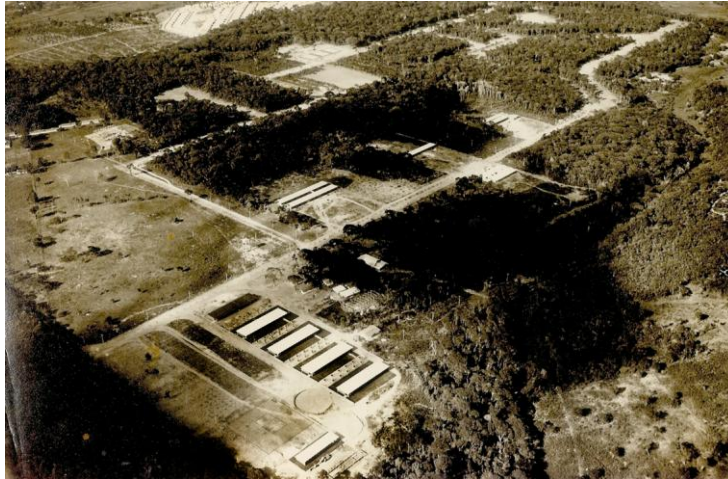
Figura 88: UFPB – Construção da cidade universitária [1968?].
