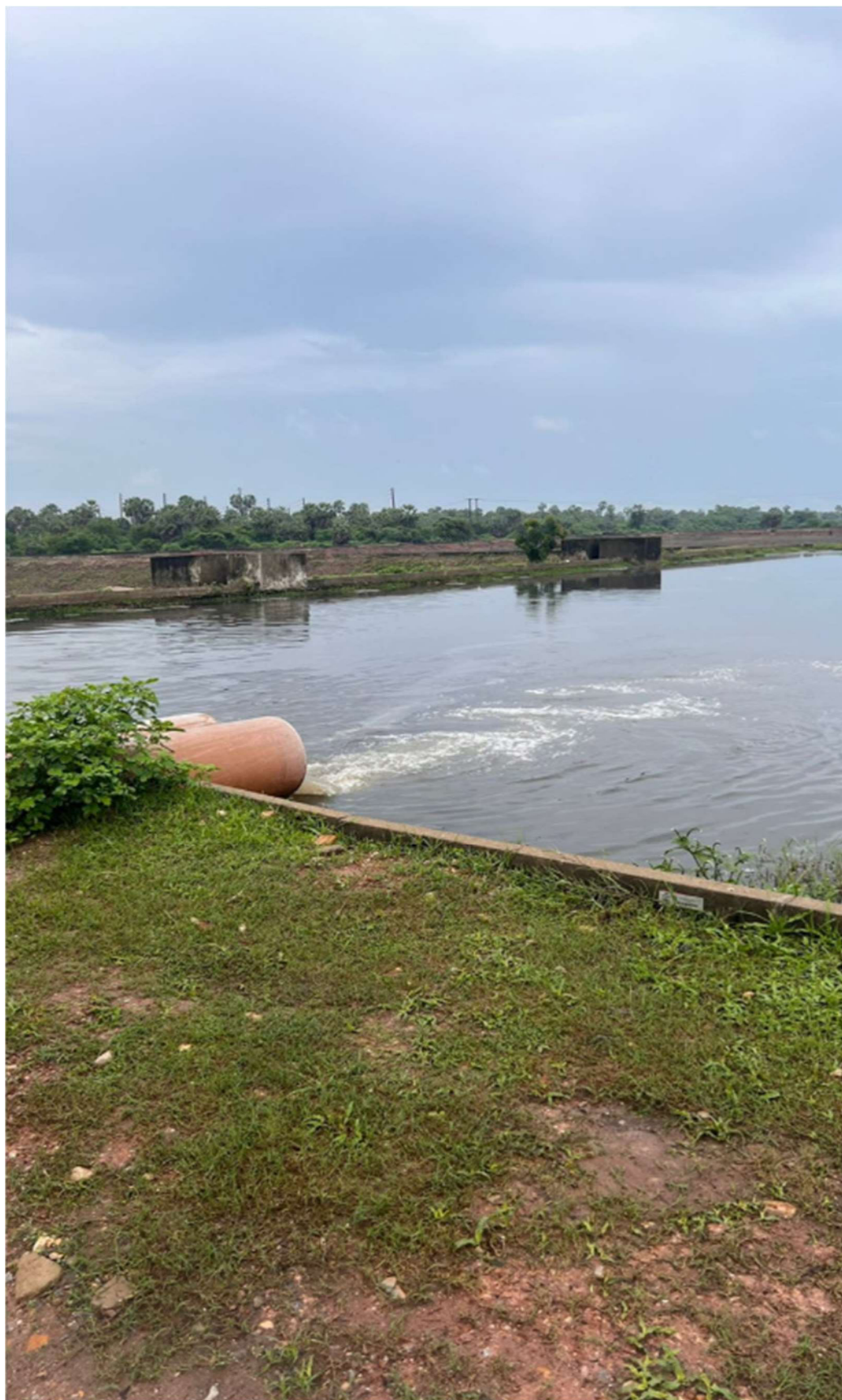
Figura 6.7 - Foto da entrada do efluente na lagoa anaeróbia
