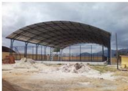
fotos da obra
