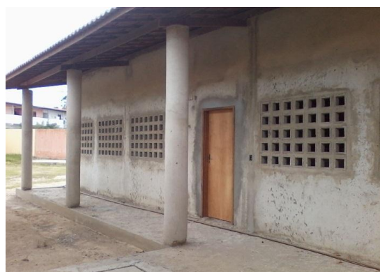
fotos da obra
