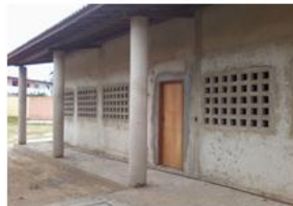
fotos da obra
