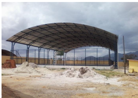
fotos da obra
