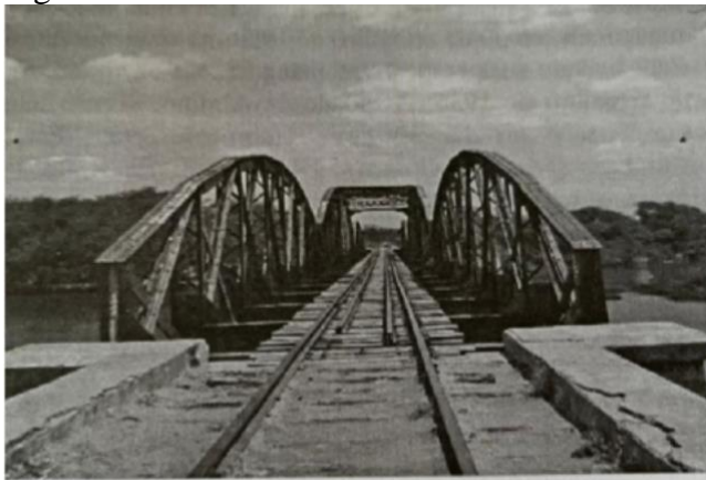
Figura 32 - Ponte Férrea sobre o Rio Mossoró - 1948
