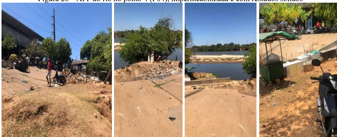
Figura 20 – APP do rio no ponto 4 (P04), impermeabilizada e com resíduos sólidos
