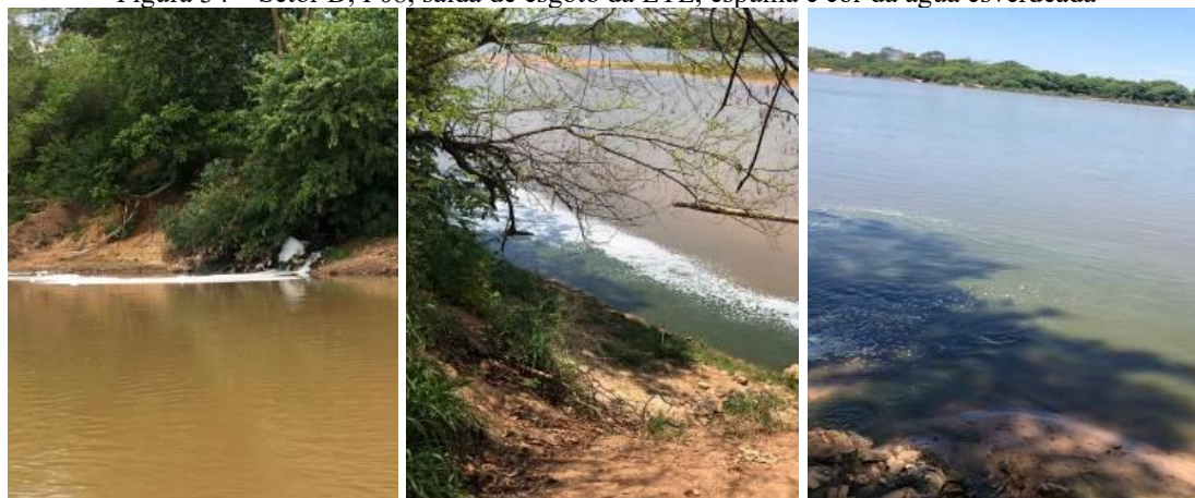
Figura 34 – Setor D, P08, saída de esgoto da ETE, espuma e cor da água esverdeada
