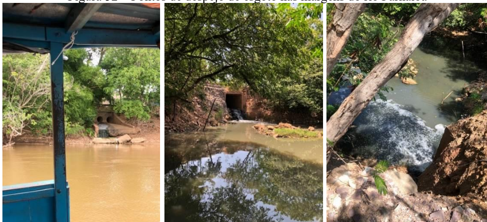
Figura 52 – Pontos de despejo de esgoto nas margens do rio Parnaíba
