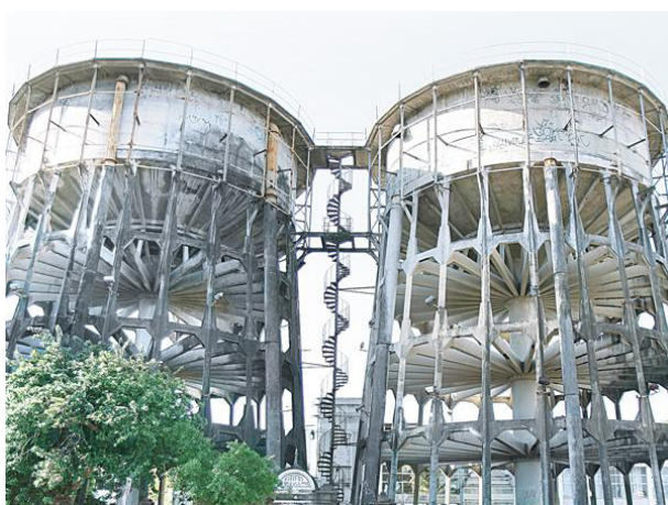
Figura 63: Reservatórios metálicos revestidos de cimento e areia da praça Visconde de Pelotas (atual Clovis Beviláqua). Fonte: Coleção Margarida Andrade.
