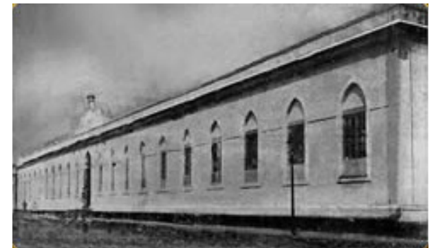
Figura 54: Santa casa da Misericórdia.
