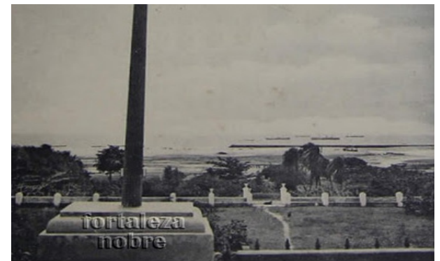
Figura 80: O 2º 3º planos do Passeio Público, vendo ao fundo o quebra-mar Hawkshaw e navios. Fonte: Álbum de vistas do Estado do Ceará, 1908.
