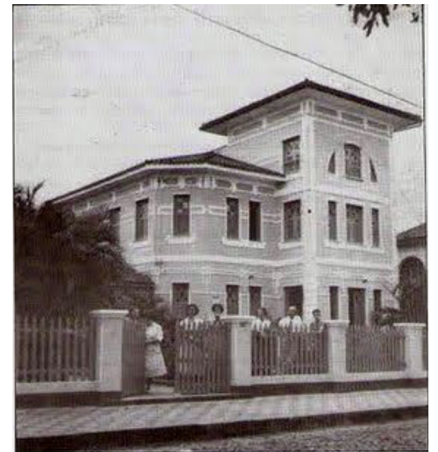
Figura 155: Palacete Oscar Pedreira (Aristides Capibaribe) situada na Avenida Filomeno Gomes.
