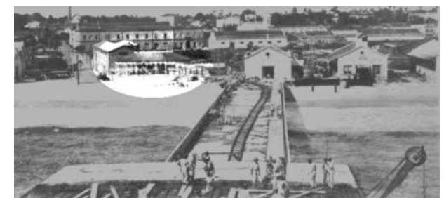
Figura 66: Viaduto Moreira da Rocha.
