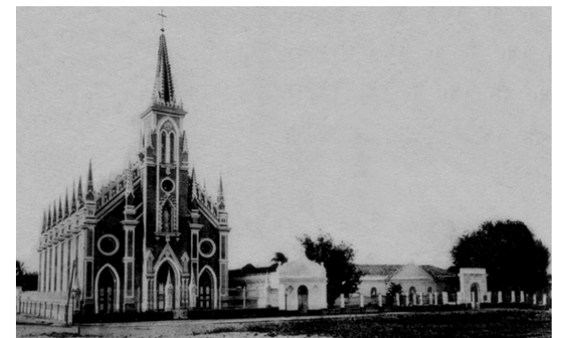
Figura 69: Colégio das Irmãs. Observar, à direita o primeiro momento do colégio com somente o pavimento térreo. Fonte: Coleção Nirez.
