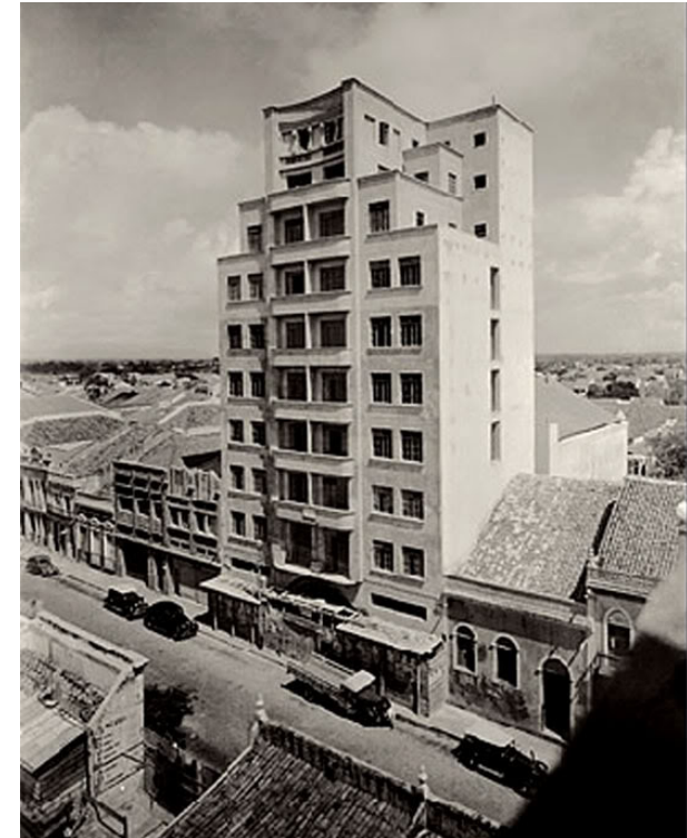
Figura 222: Cine Diogo na rua Barão do Rio Branco (antiga rua Formosa). Observar a escala do edifício com as edificações ao redor. Fonte: Coleção Nirez.
