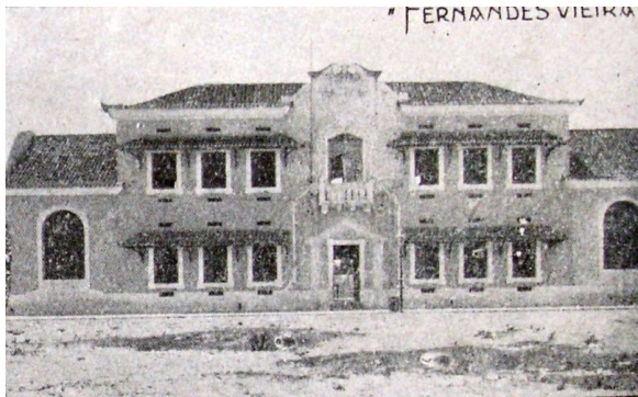
Figura 103: Fachada principal do Grupo Escolar Fernandes Vieira (atual Juvenal Galeno), 1923, projeto de Armando de Oliveira. Fonte: Álbum de Fortaleza 1931.
