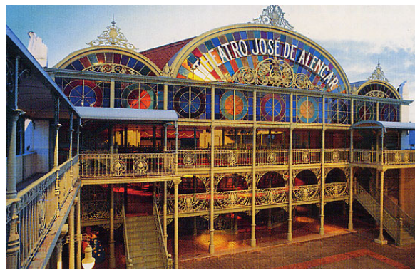
Figura 102: Fachada da platéia do Teatro José de Alencar, em estrutura metálica importada da Escócia segundo às concepções Art Nouveau. Fonte: Coleção Margarida Andrade.
