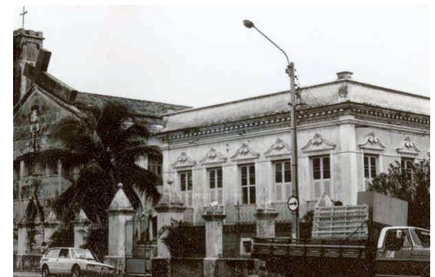
Figura 122: Casa de porão alto situada no boulevard Visconde do Cauipe nº 548 (atual 1896), (antiga Estrada de Arronches), pertencente Manços Valente Cavalcante em 1922. Fonte: Coleção Margarida Andrade.
