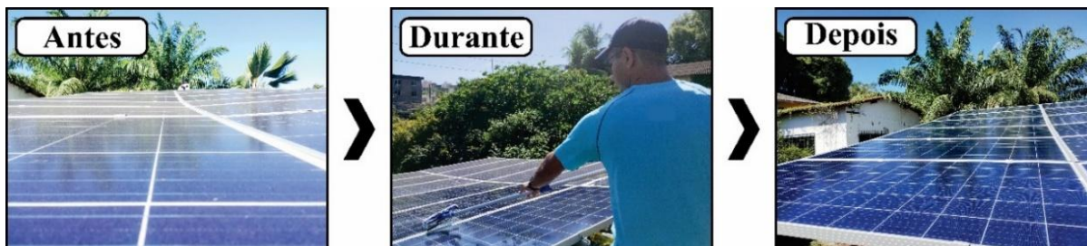
Figura 33 – Planta LEA2 antes, durante e depois da limpeza manual de 05 de julho 2023.
