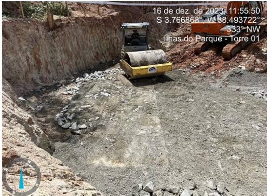
Figura 12 – Compactação final da mistura de blocos de rocha e concreto ciclópico com o uso de rolo liso vibratório
