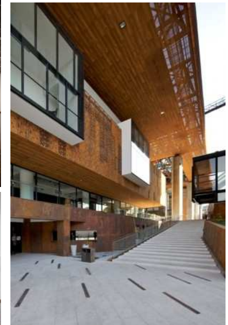
Fig.26: Pele em aço corten e grandes esquadrias localizadas em pontos estratégicos compõem a fachada
