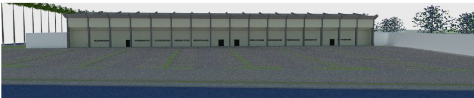
Figura 70: Vista Fachada Oeste Mini-estádio
