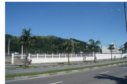
Figura 46: Vista externa CT Meninos da Vila
