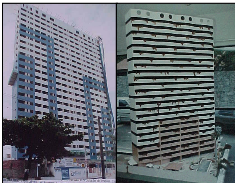
Figura 1 – fotos do empreendimento A e da maquete do empreendimento B
