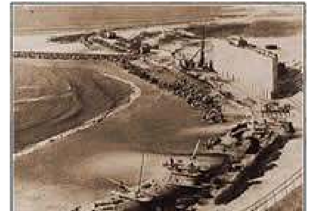
Figura 3. 2: Construção do porto do Mucuripe.
