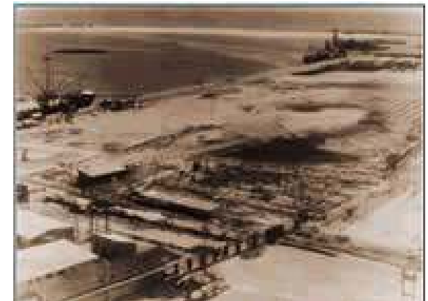
Figura 3. 3: Construção terminal de passageiros.
