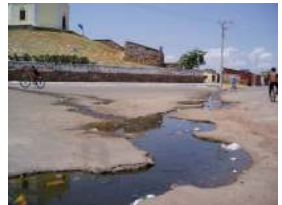
Figura 3. 27: Esgoto a céu aberto em frente ao Farol Velho.
