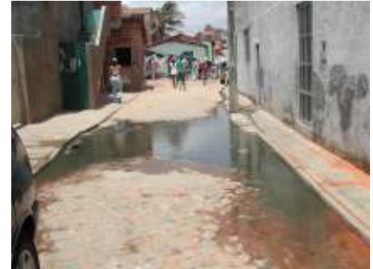
Figura 3. 26: Esgoto a céu aberto no Serviluz.
