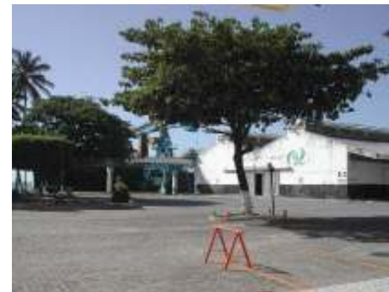
Figura 3. 10: Armazém do Porto.
