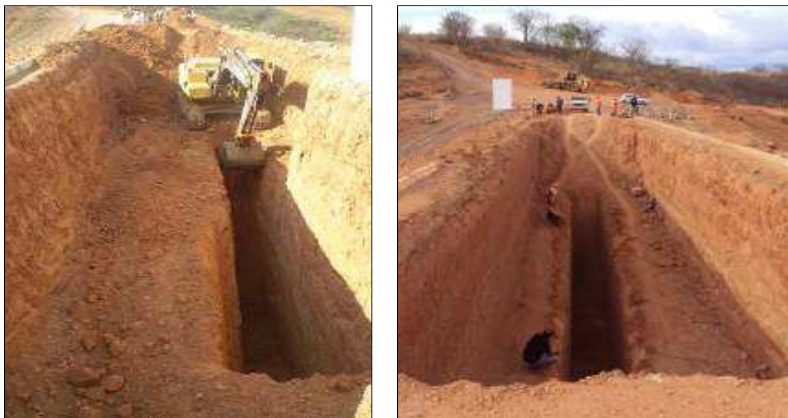
Figura 50 – Escavação da vala e trincheira das ombreiras esquerda (à esq.) e direita (dir.)
