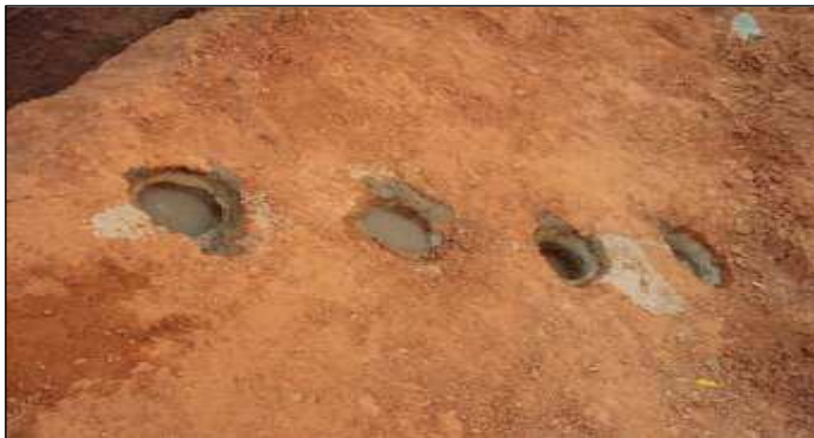
Figura 52 – Furos de injeção da calda de cimento ao final do processo
