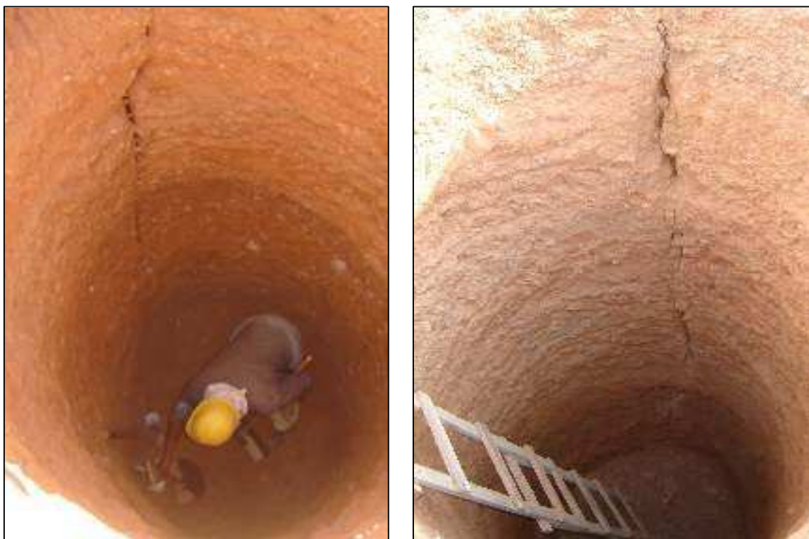
Figura 49 – Poços de inspeção de fissuras nas ombreiras esquerda (à esq.) e direita (dir.)
