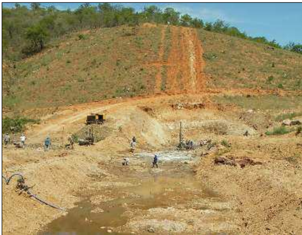
Figura 42 – Execução da trincheira de vedação ( cut-off ) de Piaus.
