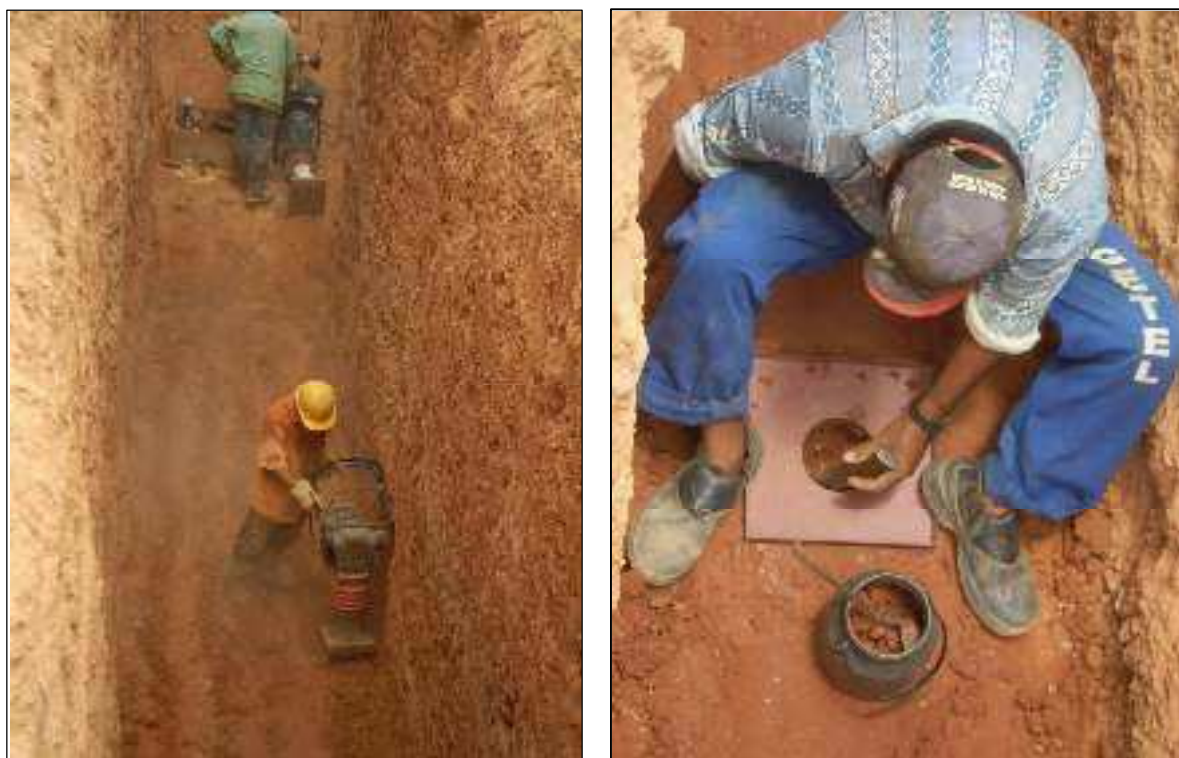
Figura 51 – Compactação do solo-bentonita na trincheira (à esq.) e controle em campo da compactação
