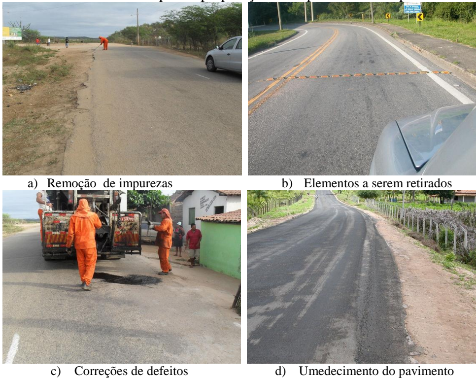
Figura 2.14 - Procedimentos para a preparação da superfície a ser aplicada o MRAF
