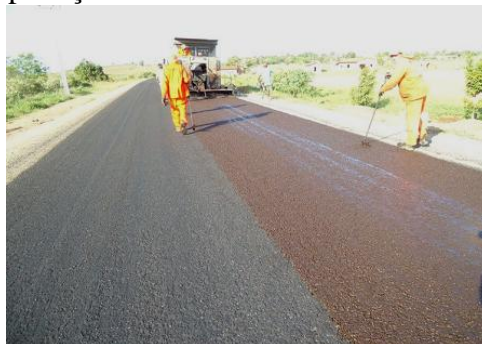
Figura 2.25 - Aplicação de MRAF sobre TSD no interior da Paraíba
