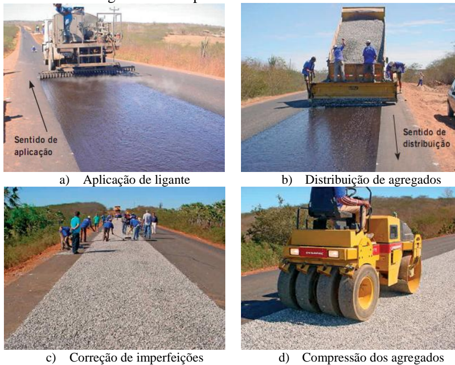
Figura 2.6 - Etapas construtivas de um TSS
