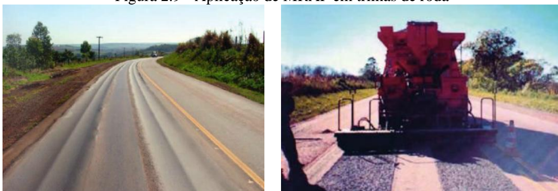
Figura 2.9 - Aplicação de MRAF em trilhas de roda
