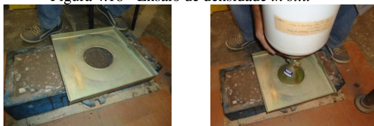
a) Furo perfurado na base de solo-brita b) Preenchimento do furo com areia
