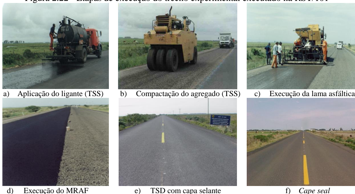
Figura 2.22 - Etapas de execução do trecho experimental executado na RST/101
