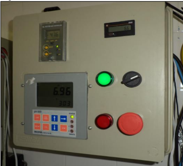
Figura 12 - Quadro elétrico para registro dos pulsos gerados pelo deslocamento de líquido durante a produção de biogás.
