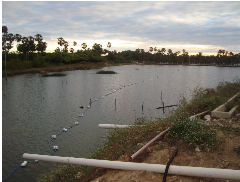
Figura 8 – Vista geral da mangueira flexível adaptada no motor de captação do efluente armazenado na bacia de sedimentação, Aracati-CE (2011).
