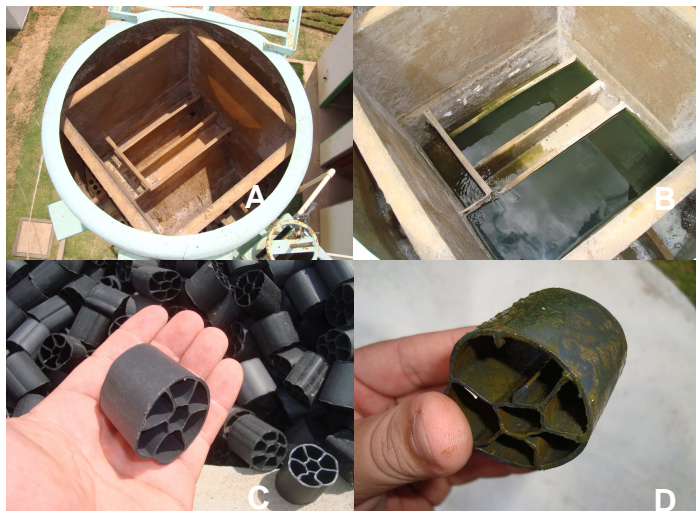
A – Vista superior do reator aeróbio (FSA); B – Vista geral do decantador secundário lamelar; C – Meio suporte MSS 265; D – Formação do biofilme.
