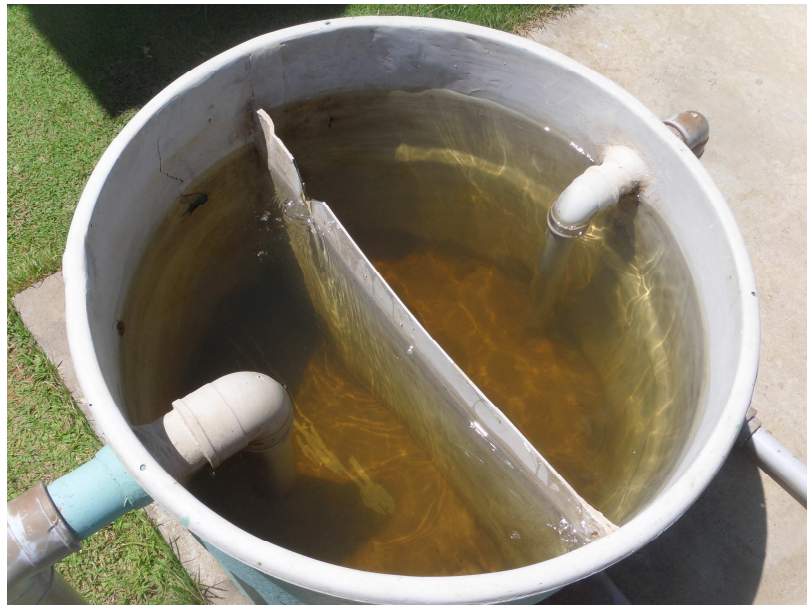
Figura 11 – Vista geral do tanque de armazenamento instalado após o reator FSA para remoção partículas biológicas desprendidas do meio suporte e sólidos sedimentáveis, Aracati-CE (2012).
