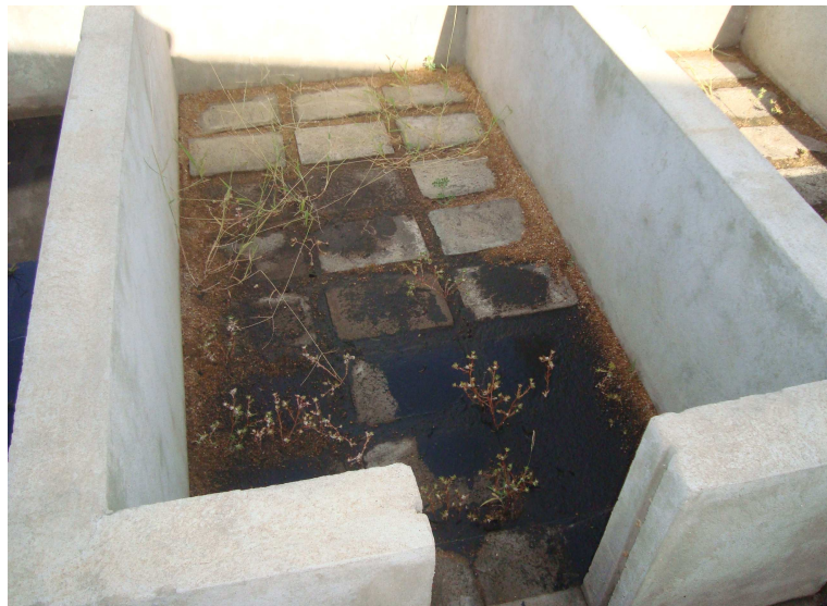
Figura 23 – Vista geral dos sólidos descartados dos reatores biológicos (UASB e FSA) no leito de secagem, Aracati-CE (2012).
