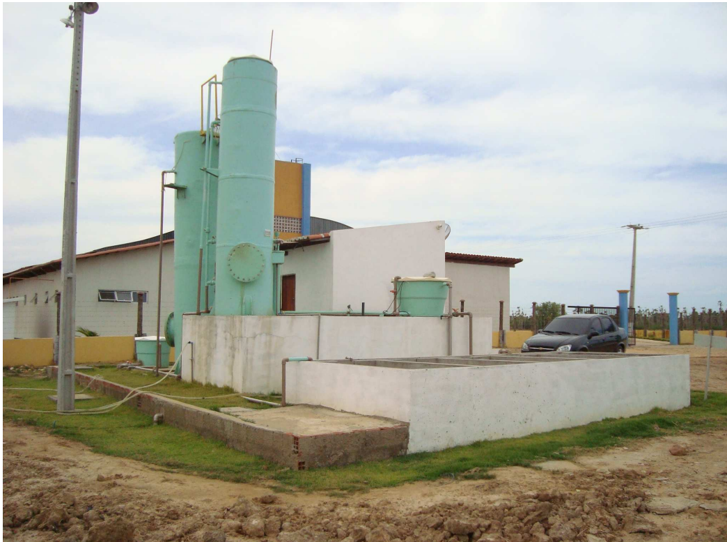
Figura 21 – Vista geral da Estação de Tratamento de Esgoto (ETE) piloto implantada, Aracati-CE (2012).
