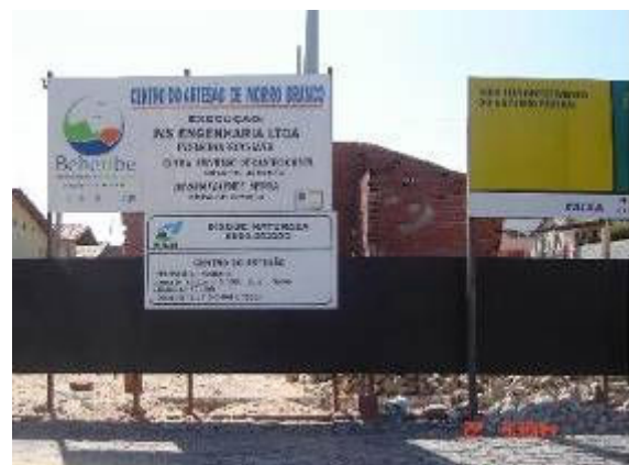
Figura 35: Construção do Centro do Artesão em Morro Branco
