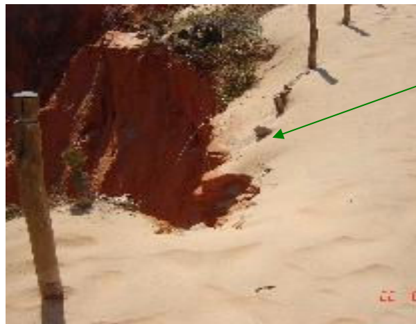
Figura 36: Riscos de acidentes, verifica-se o acúmulo de areia sob as cercas.
