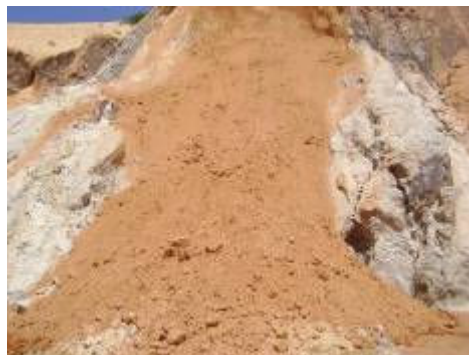
Figura 52: Deslizamento de terras na trilha do labirinto – precisa de um monitoramento.
