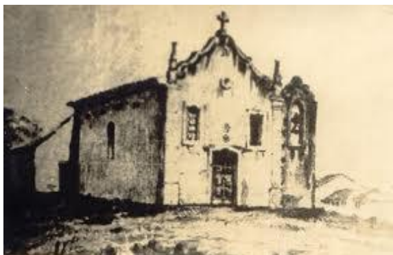
Capela de Nossa Senhora do Ó de 1859. Construção de alvenaria 62
