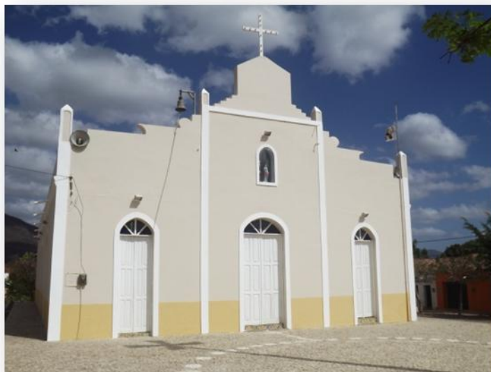
Foto 6 - Fachada atual da capela da Vila Oiticicas
