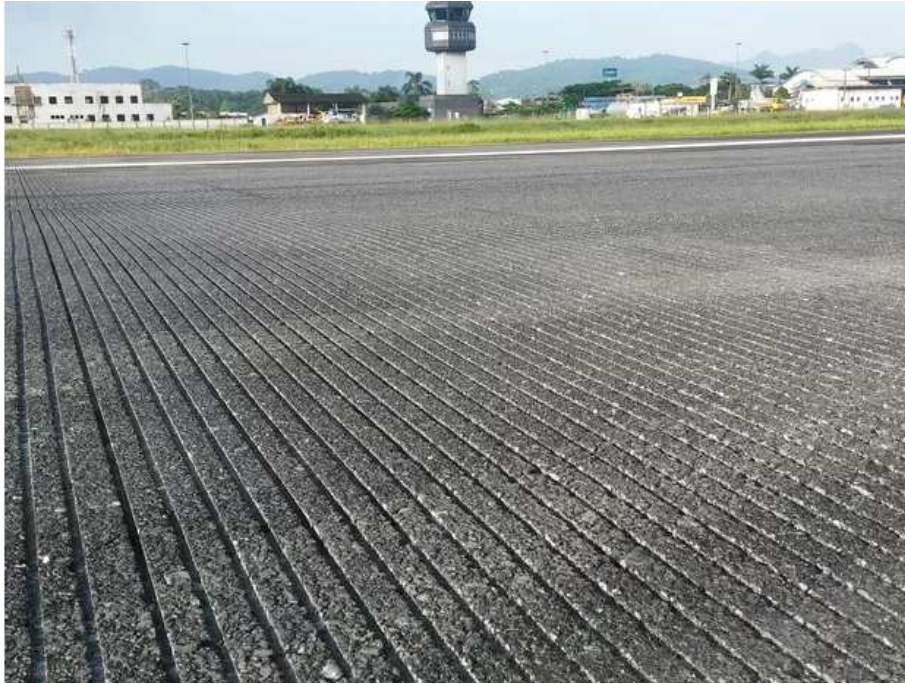
Figura 6 – Grooving no Aeroporto de Joinville, Santa Catarina, Brasil.
