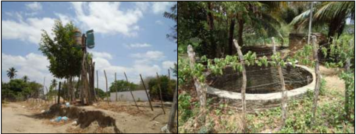
Figura 08- Aspectos relativos à captação de água subterrânea (Poço profundo e poço amazonas)
