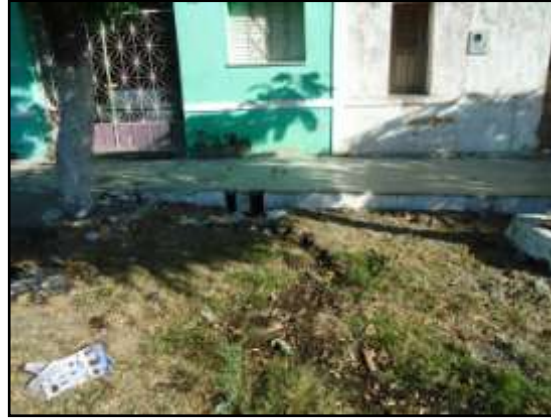
Figura 24.2- Efluentes domésticos lançados a céu
