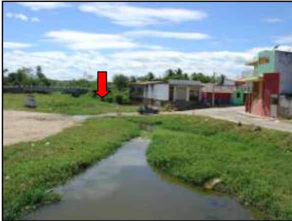
Figura 52- Rio Curtume antes da construção das paredes
