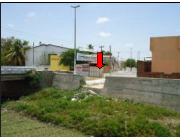
Figura 54- Quebra das paredes para viabilizar o escoamento superficial
