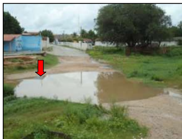
Figura 57- Canalização do rio Curtume – início da quadra chuvosa
