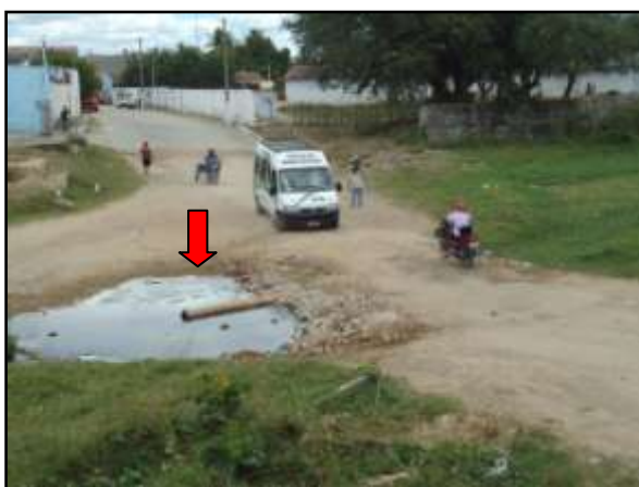
Figura 56- Canalização do rio Curtume – período seco
