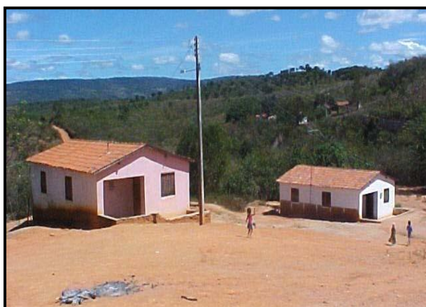
FIGURA – 43. Estrutura atual das casas do projeto moradia. Foto: Judson Jorge, 2008
