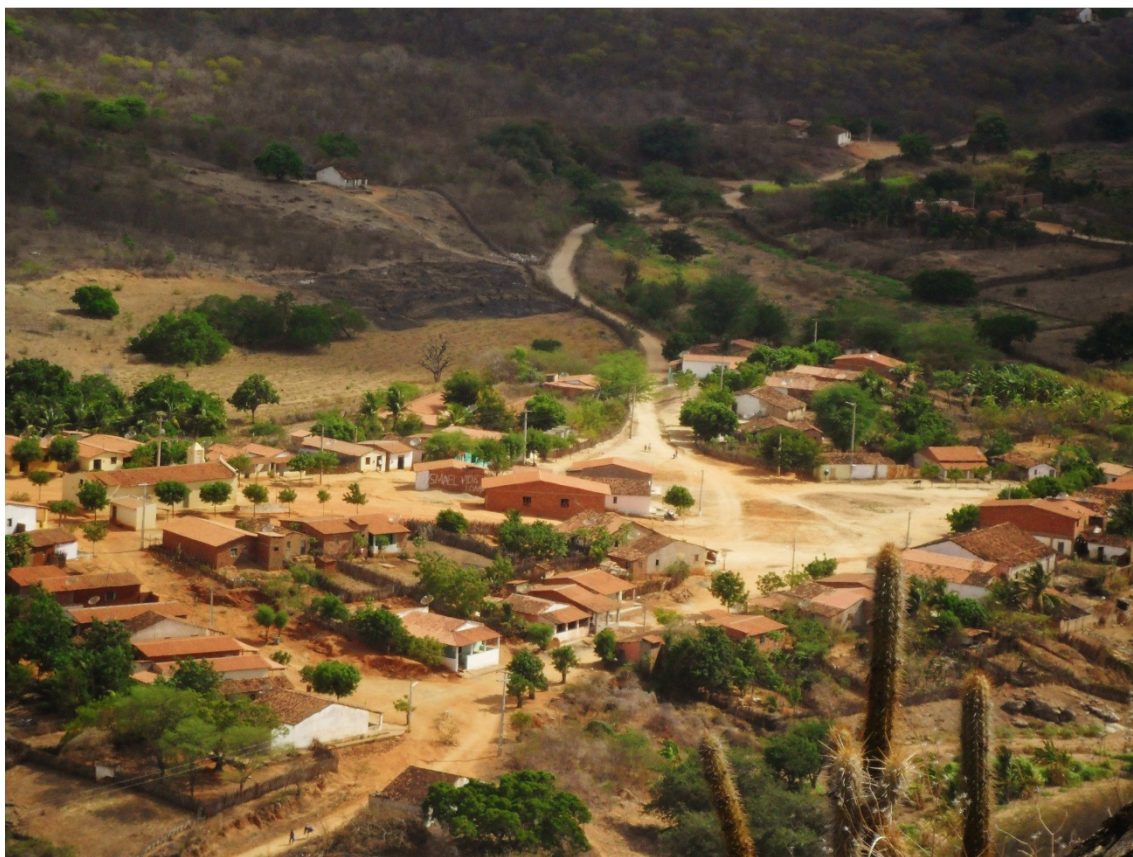
Figura 1: Vista aérea do centro do povoado, onde se localiza a igreja e a escola.
