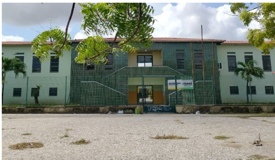
Figura 2: Vista frontal da E.E.M Liceu de Messejana (após reforma) - Retirada de registro disponível no Google Earth.
