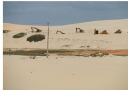
Figura 53.5: Obras da instalação da usina eólica em Mundaú
