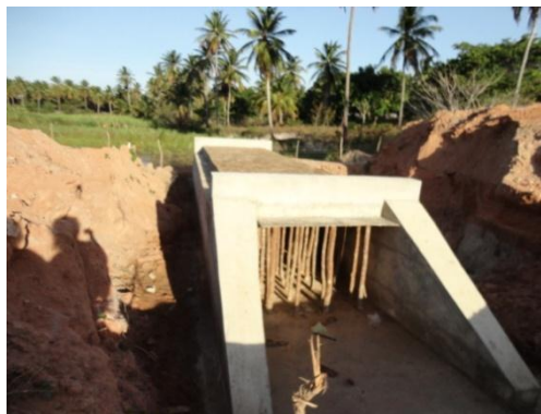
Figura 27.7: Construção da estrada que liga Canaã e Panã
