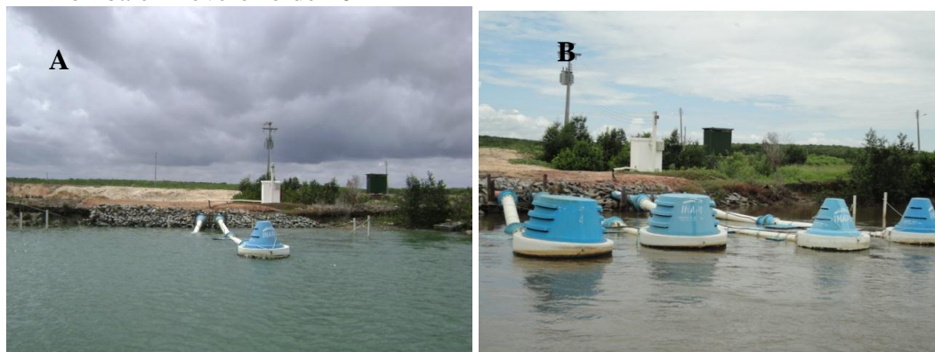
Figura 30 – Bombas de captação de água para os viveiros de camarão em Mundaú
