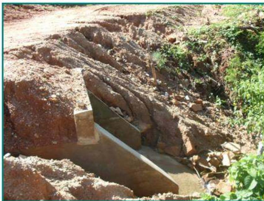
FIGURA 56 - Cicatrizes de erosão provocadas pelo escoamento superficial concentrado sobre as superfícies côncavas da vertente E da Conceição e canalização de rio. Fonte: Saraiva Junior, Fevereiro - 2009.
