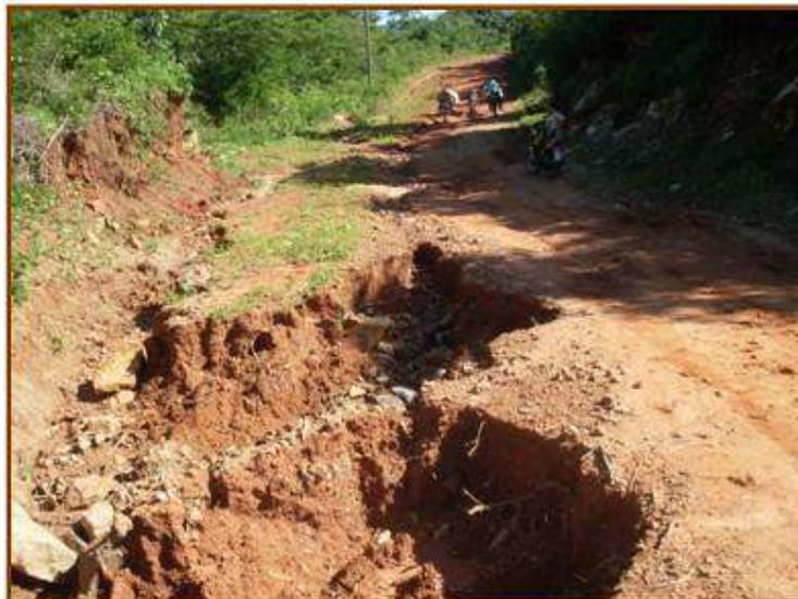
FIGURA. 57- Erosão provocada pelo escoamento superficial concentrado sobre as superfícies côncavas da vertente E da Conceição. Fonte: Saraiva Junior, fevereiro - 2009
