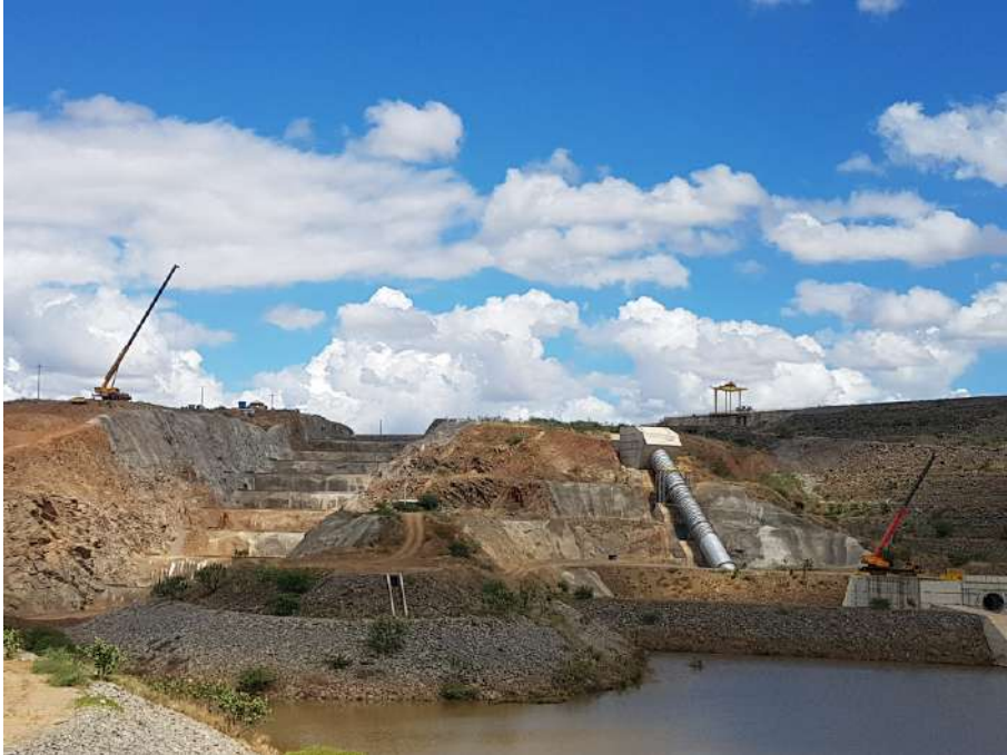
Figura 20 – Construção da Barragem da Transposição em Jati-CE, 2019
