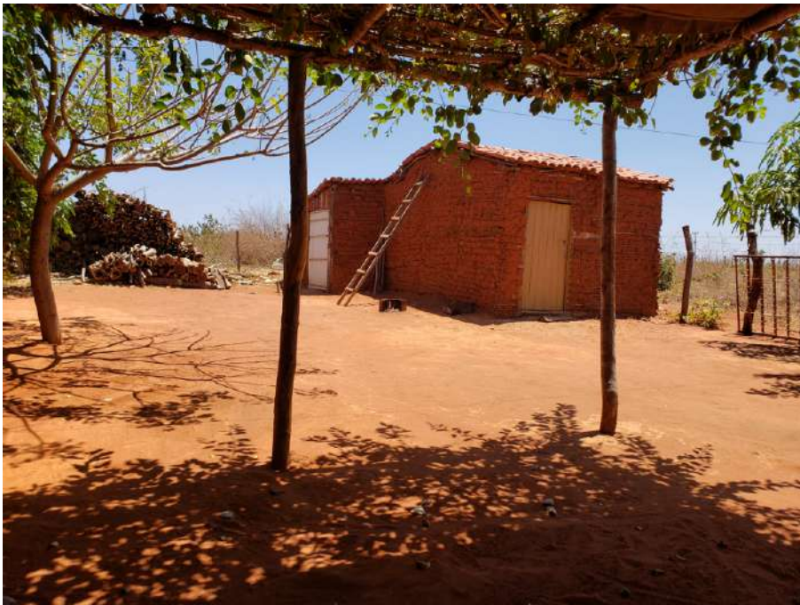
Figura 19 – Construção em taipa no quintal de casa da VPR Vassouras em Brejo Santo-CE
