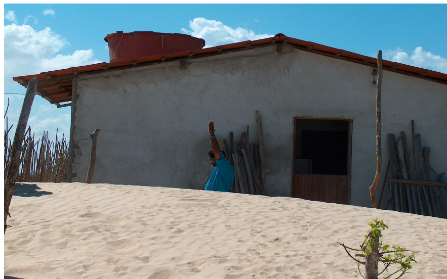
Figura 24 – Invasão de areia na residência chega a 1metro de altura. Fonte: IBAMA - 2006.
