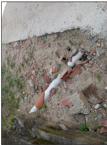
Exposição de encanamentos que direcionam o despejo das "águas servidas" para os canais de concreto. Foto por: Ícaro Maia, 2010.
