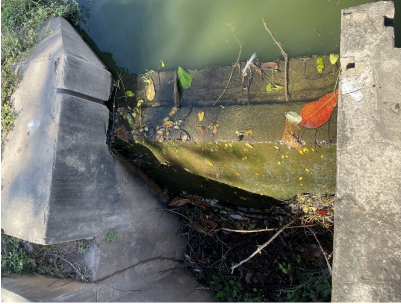
Figura 8 – Interior da comporta de escoamento do tanque.
