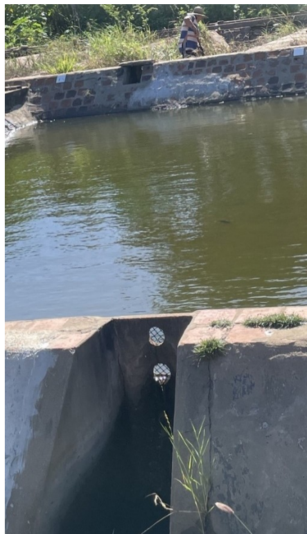
Figura 6 – Drenagem por nível.
