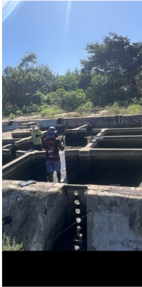
Figura 7 – Utilização de telas na drenagem.
