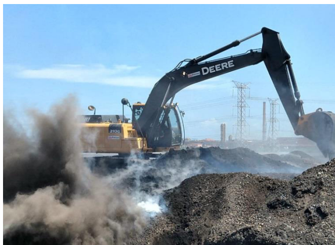
Figura 2.2: Geração de poeira devida à granulometria das cinzas
