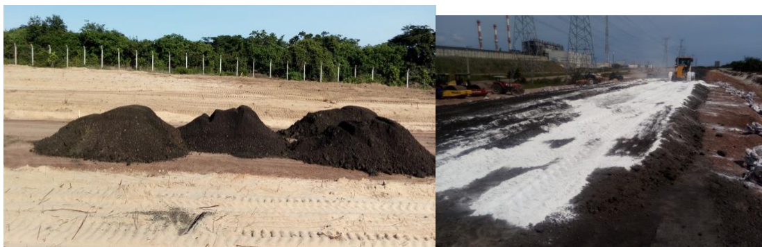
Figura 4.1: Execução da camada de base (mistura dos materiais)
