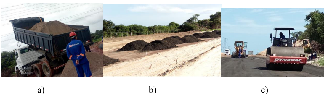
Figura 3.3: Execução da camada de sub-base
