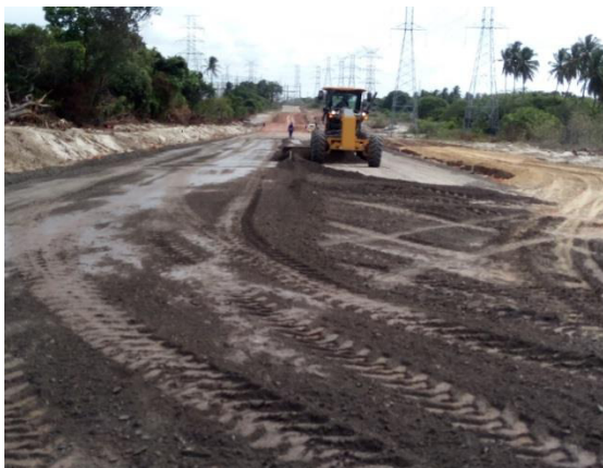
Figura 3.1: Aspecto da cinza em campo com teor de umidade acima do ótimo
