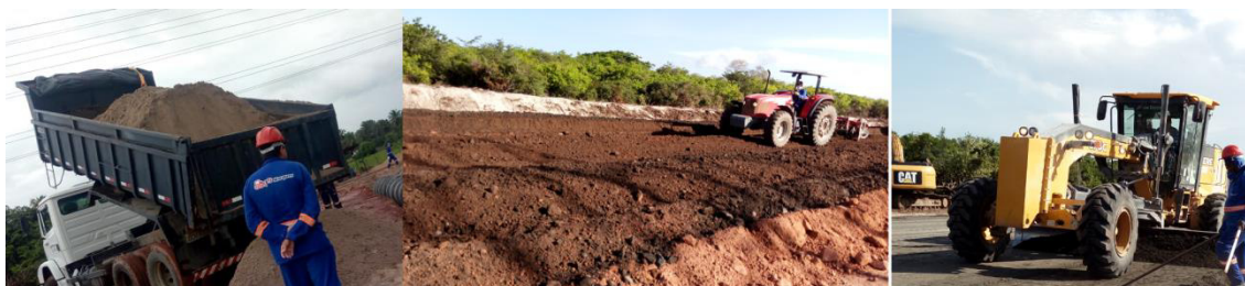
Figura 3.2: Equipamentos utilizados na execução da camada de sub-base
