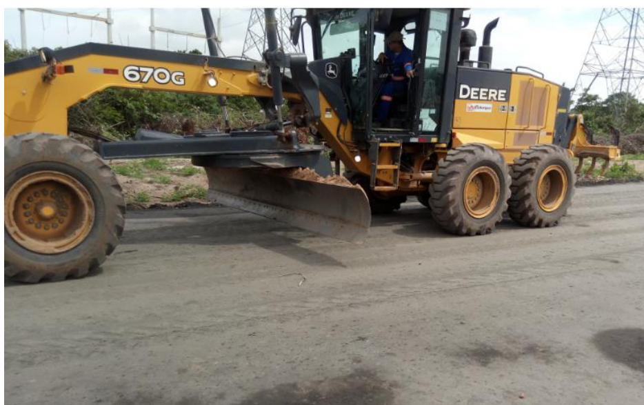
Figura 4.4: Acabamento da Camada
