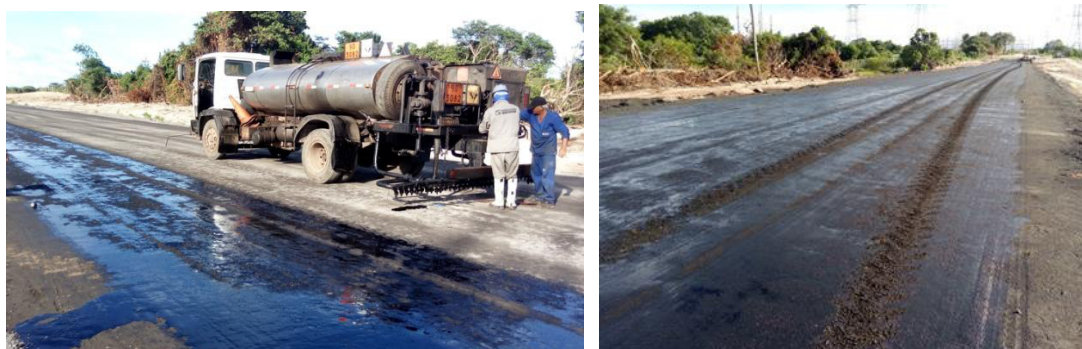
Figura 24 – Falhas na imprimação: (a) falha de bico; (b) ausência do ligante em alguns trechos.
