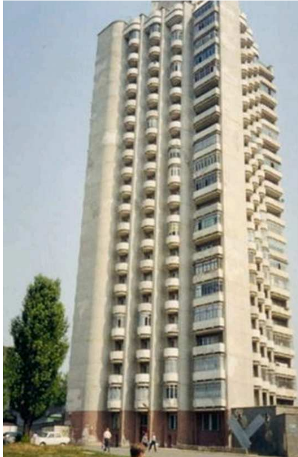
Figura 1 – O primeiro edifício residencial feito de concreto álcali ativado em 1989 em Lieptsk.
