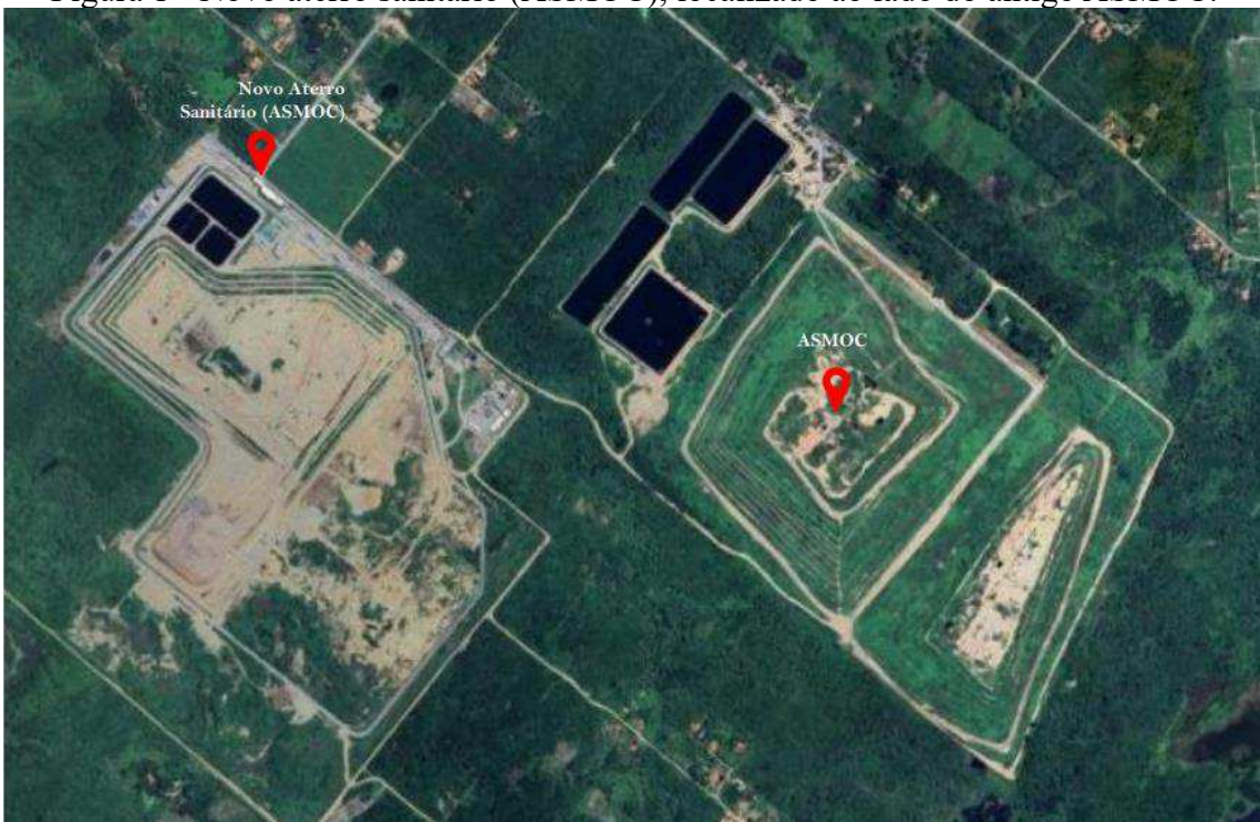
Figura 1 - Novo aterro sanitário (ASMOC), localizado ao lado do antigo ASMOC.
