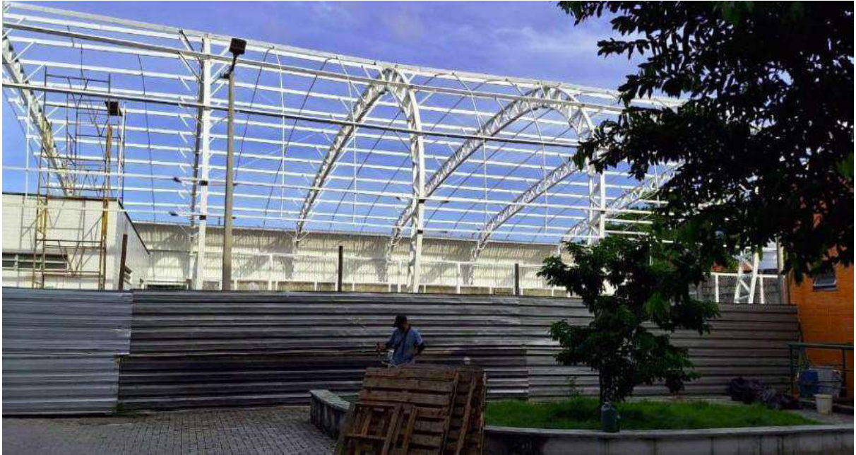
Figura 3: Escola Professora Adalgisa Bonfim Soares, Fortaleza, CE. Construção da quadra de esportes.
