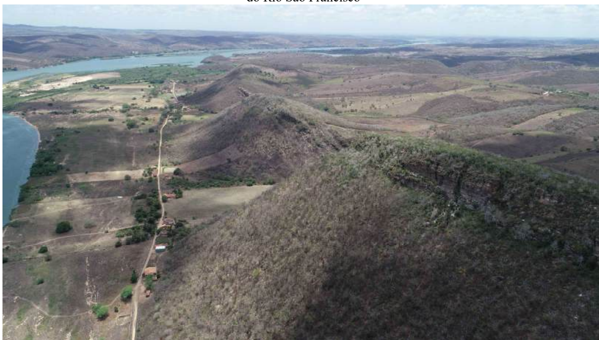
Figura 29 - Vista aérea da unidade dos maciços residuais. Ao centro, a Serra da Tabanga, em Gararu, às margens do Rio São Francisco
