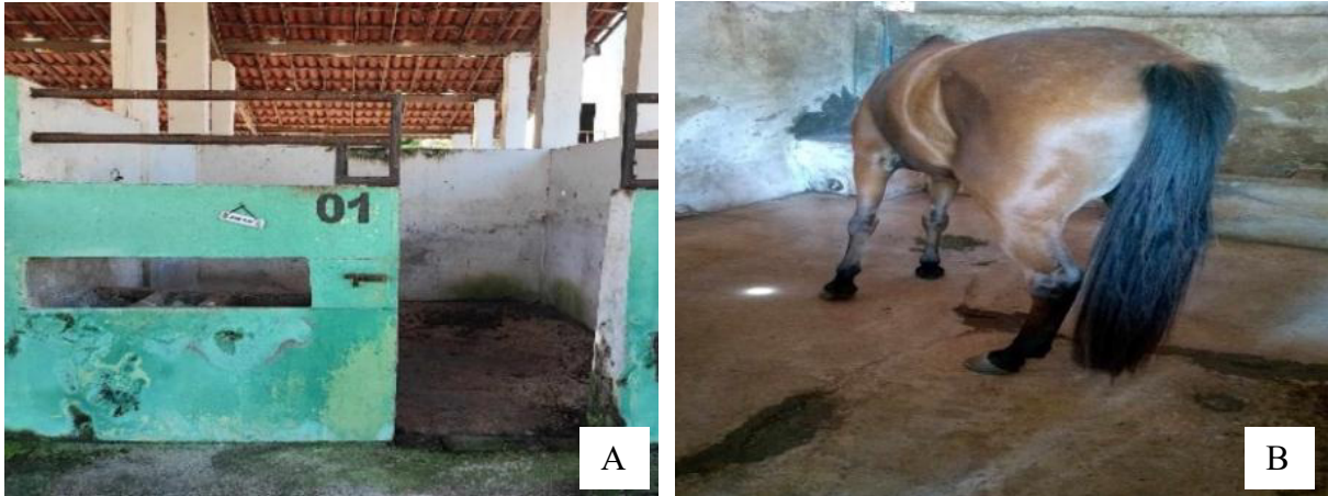
Figura 3 - Baia vazia (A) e piso com rachaduras (B)
