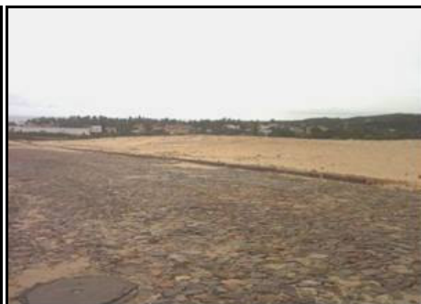
FIGURA 50 – Área de dunas móveis loteadas, com instalação de rede de esgoto.
