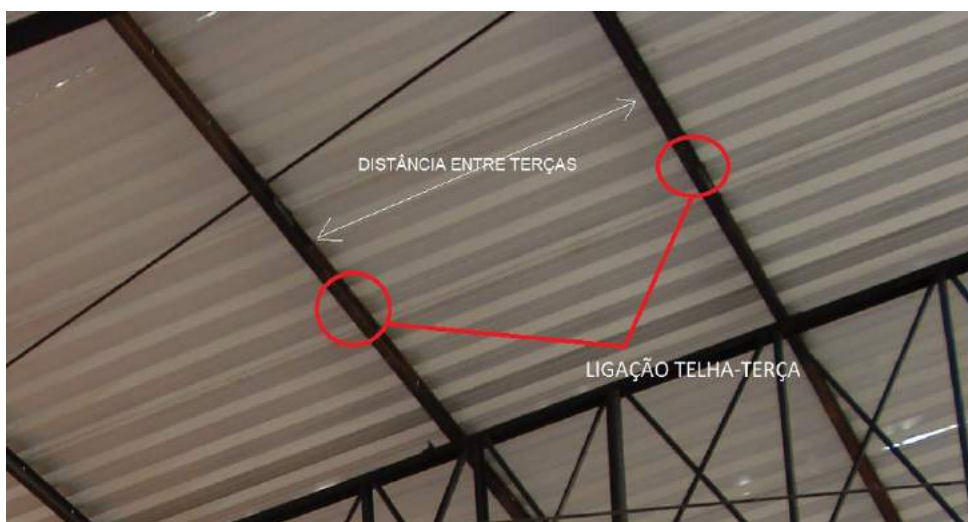
Figura 1.2 – Ligação telha-terça em cobertas metálicas.
