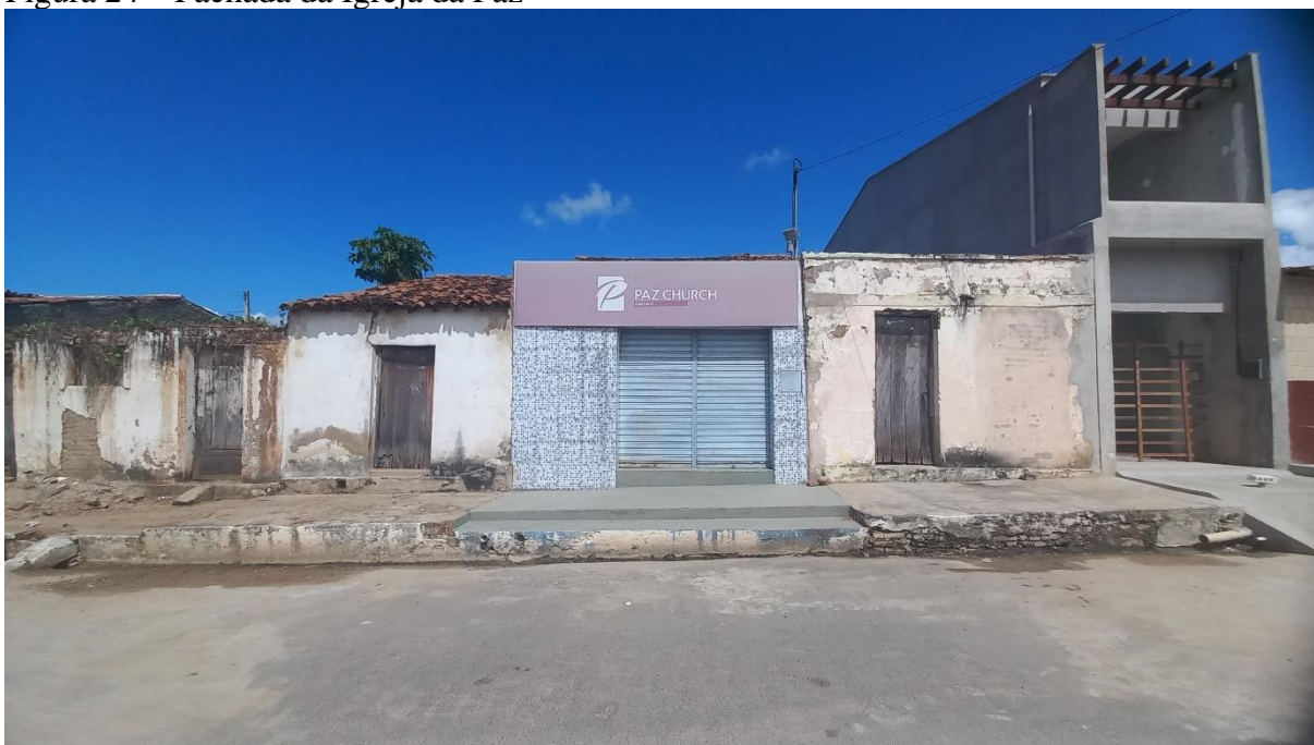
Figura 24 – Fachada da Igreja da Paz
