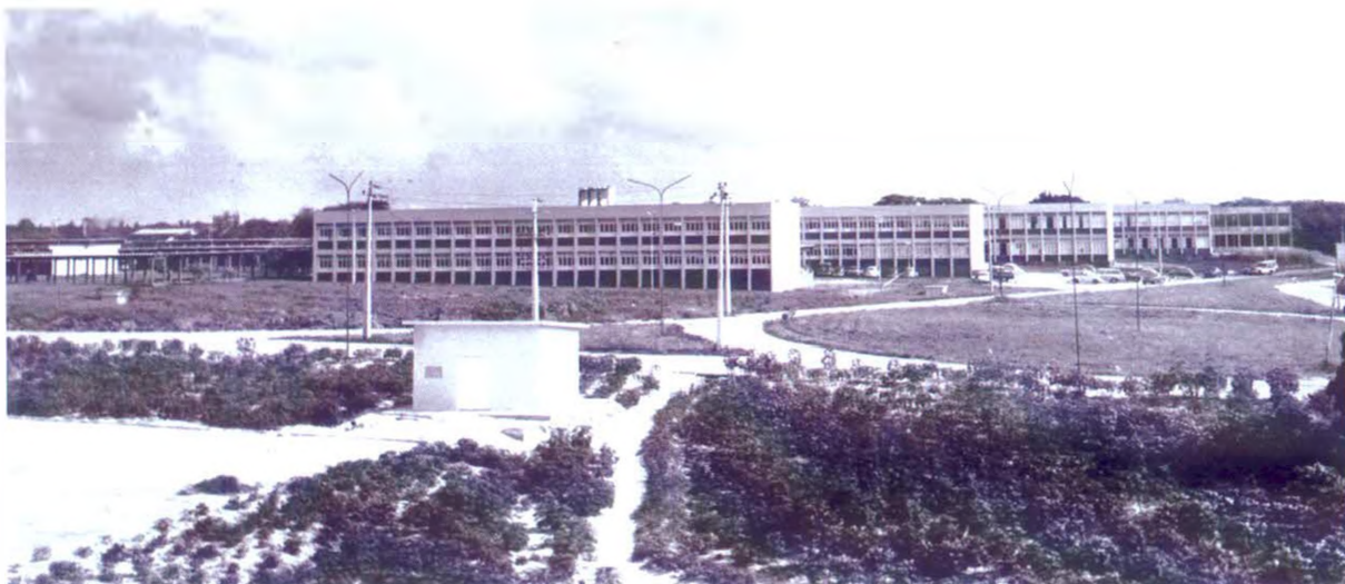
Fig. 4.6 – Blocos – Área I – Pici. A arquitetura de formas puras evidencia a influência do Movimento Racionalista – década de 1970.
