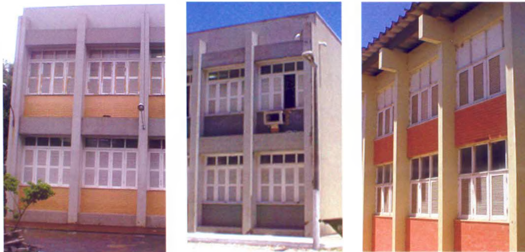
Fig. 4.5 – Fachadas com estrutura aparente, esquadrias padronizadas e revestimentos cerâmicos utilizados.
