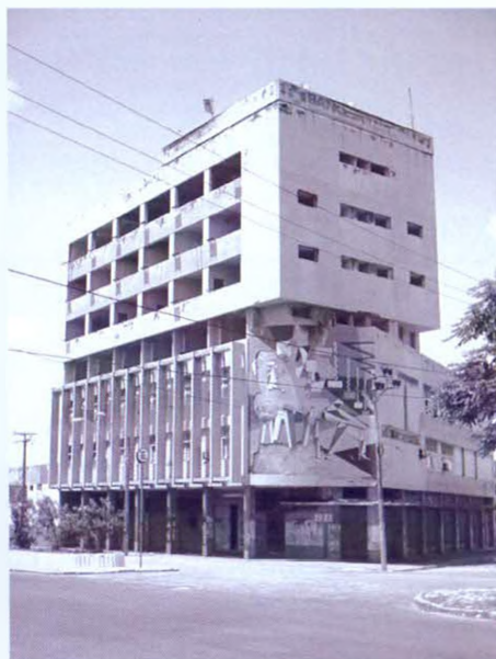
Fig. 1.3 – Centro dos Exportadores – Fortaleza – CE – 1963. Projeto: Arquiteto Neudson Braga.
