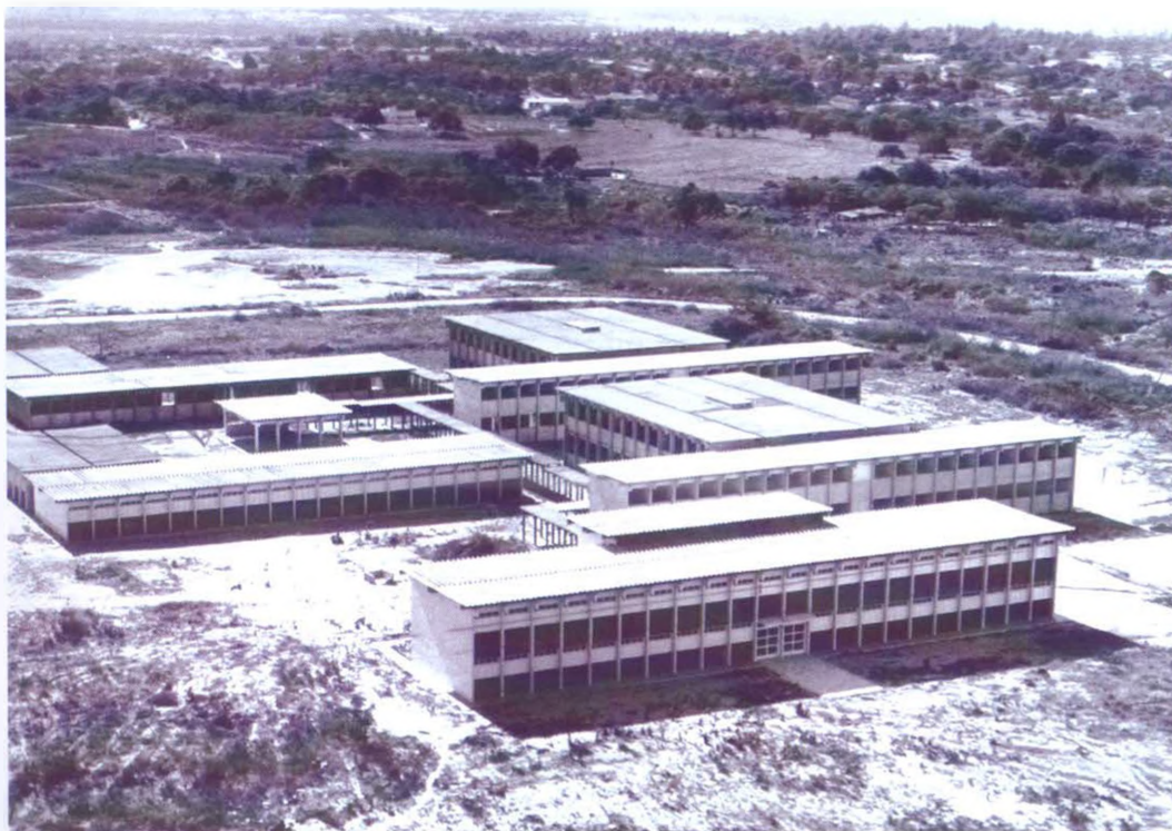
Fig. 3.6 – Vista dos blocos na Área I – Pici, década de 1970.
