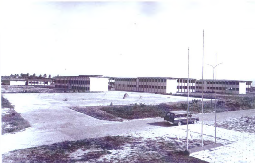
Fig. 3.10 – Vista dos blocos na Área I – Pici, década de 1970.
