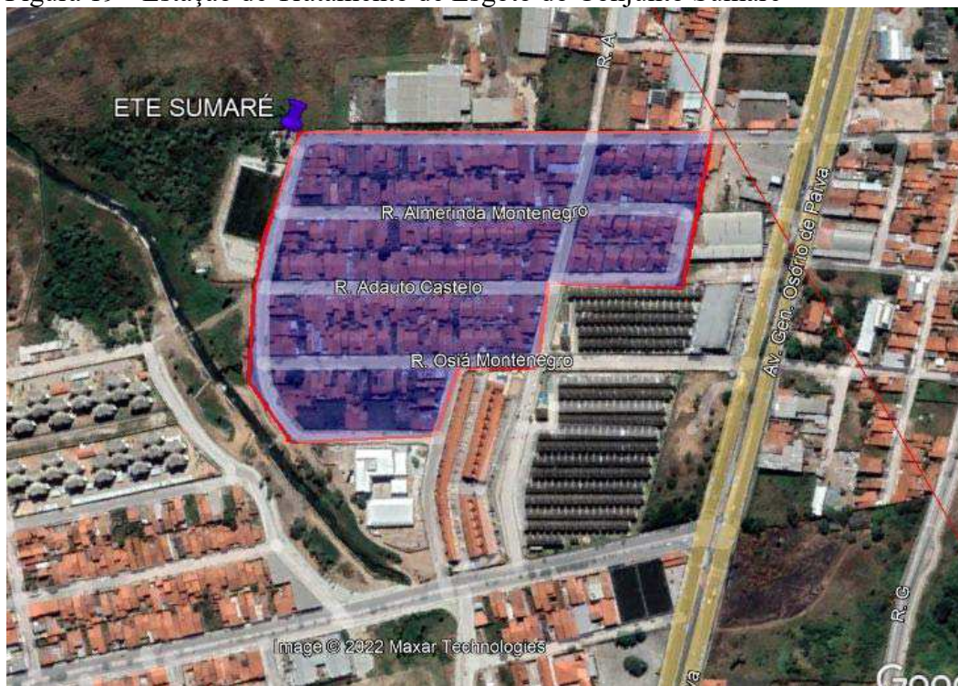
Figura 19 - Estação de Tratamento de Esgoto do Conjunto Sumaré
