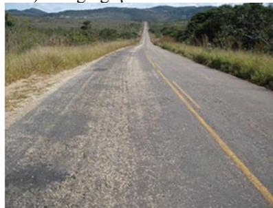
f) penteadura por falha de bico
