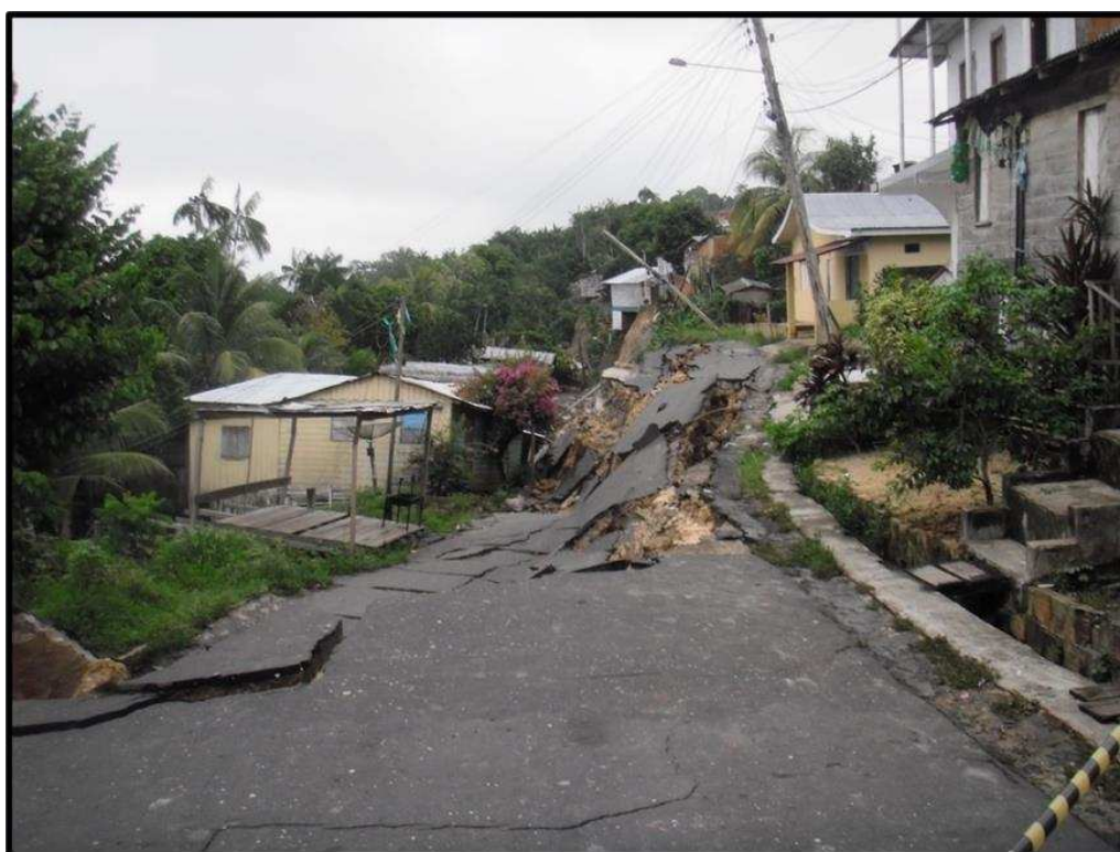
Figura 70 – Rua após movimento de massa em 11 de outubro de 2010.
