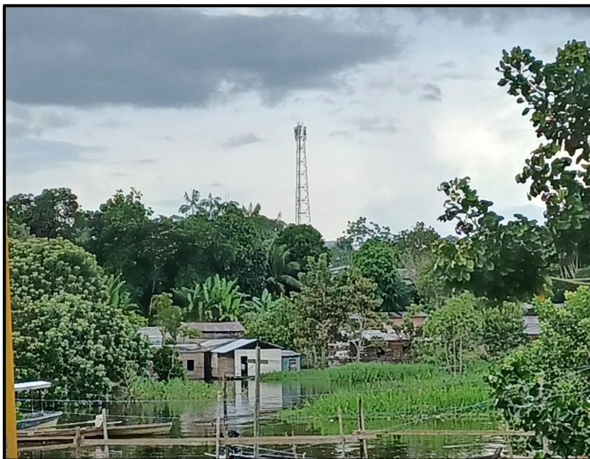
Figura 33 – Casas dispostas na Planície Fluvial do Solimões.
