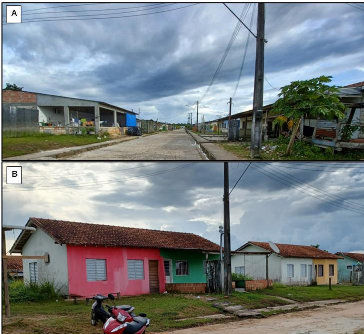
Figura 84: Conjunto habitacional construído para os desabrigados.
