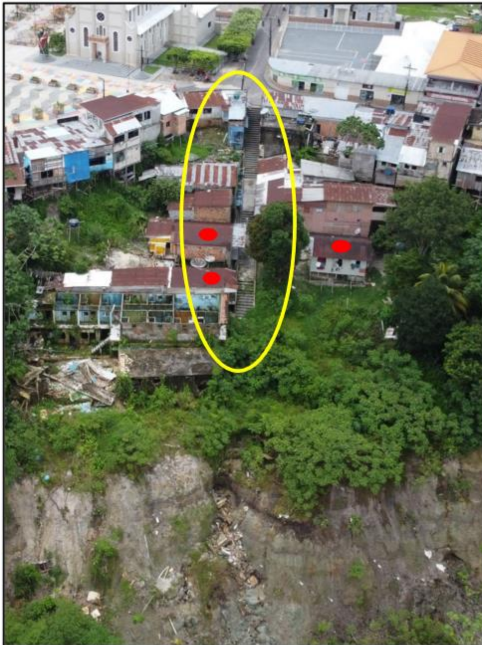
Figura 62 – Escadaria do Sacrifício em 2024
