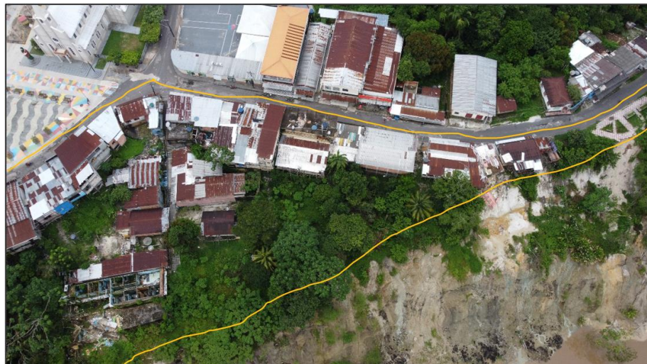
Figura 83: Área de risco delimitada atualmente em que há comércios de peruanos.
