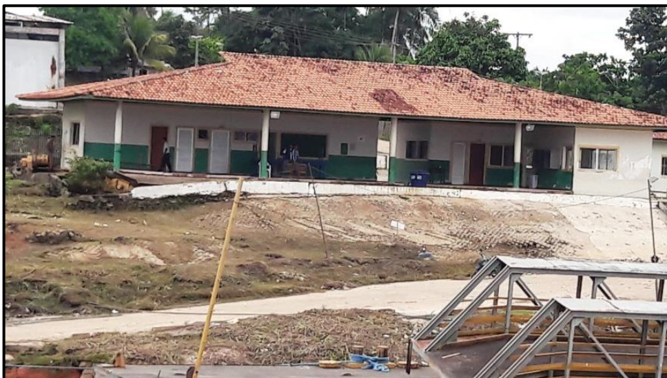
Figura 23 – Hidroviária de São Paulo de Olivença demolida em 2023
