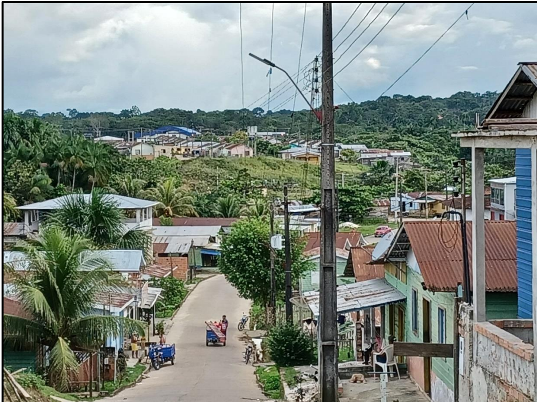
Figura 26: Construções sobre topos de morros e áreas de declives
